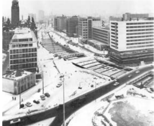
Coolsingel winter 1963 opengebrouwen voor de aanleg van de ondergrondse metro.
