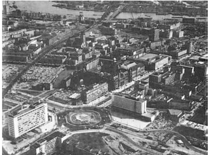
Binnenstad Rotterdam 1967 met een verzameling aan krachtige bouwvolumes, met op de voorgrond Hofplein.
