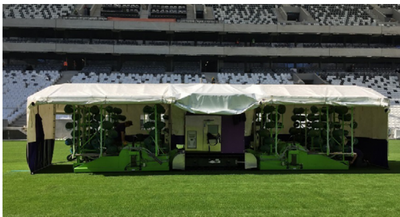
Rys. 17 Montaż zszywanej trawy hybrydowej
