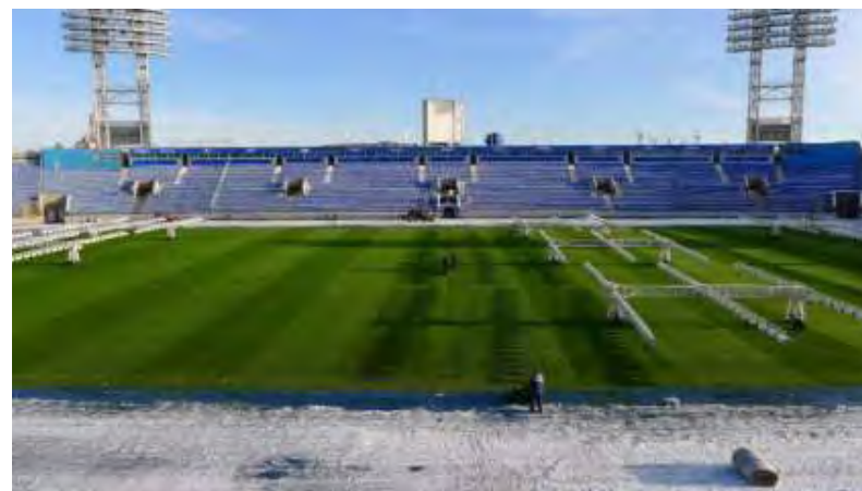
Rys. 34 Lamy do naświetlania murawy używane w celu regeneracji trawy w okresie wiosennym; ciepło wytwarzane przez lampy pozwala również na przywrócenie trawy do poprzedniego stanu
