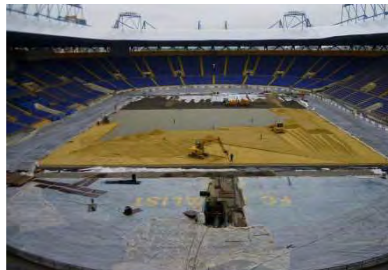
Rys. 7 Kształtowanie spadku murawy zgodnie z kątem nachylenia podłoża.
