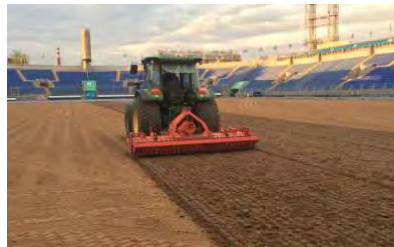
Rys. 15 Montaż wzmocnionej warstwy korzeniowej
