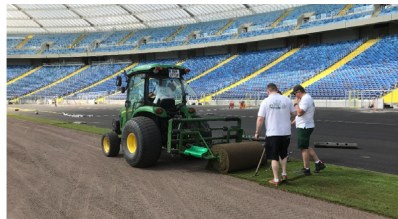
Rys. 24 Montaż murawy
