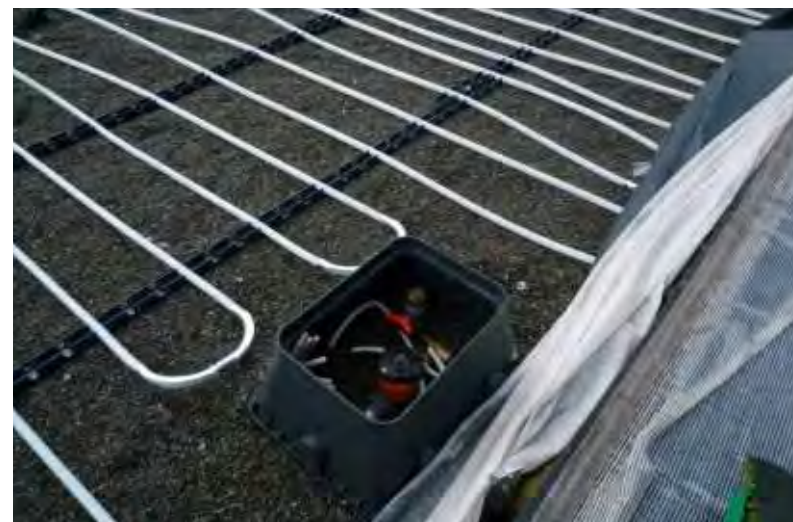
Rys. 9 Montaż modułu sterowania systemem nawadniającym
