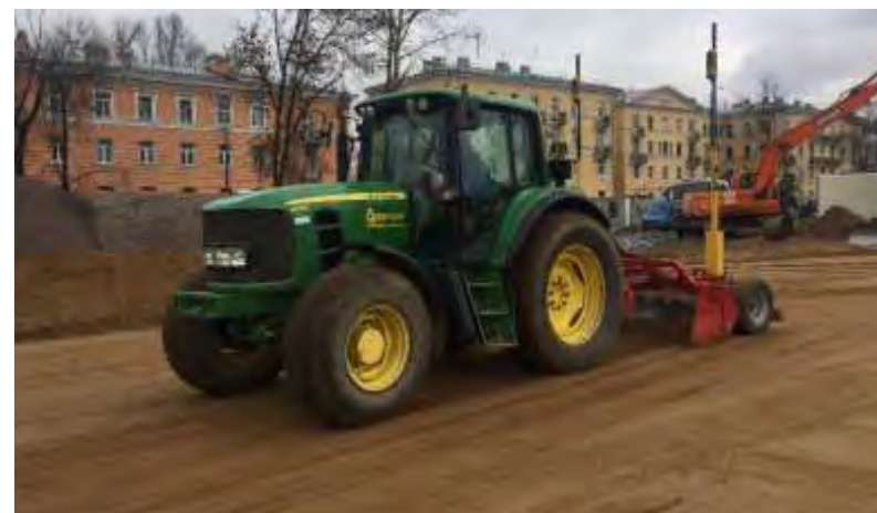
Rys. 13 Niwelacja tolerancji z wykorzystaniem lasera.
