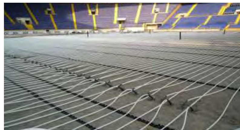
Rys. 10 Montaż podziemnego systemu grzewczego.
