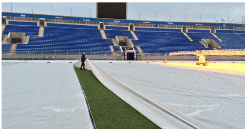
Rys.30 Podnoszenie osłony przeciwnieogowej w celu kontroli stanu murawy.
