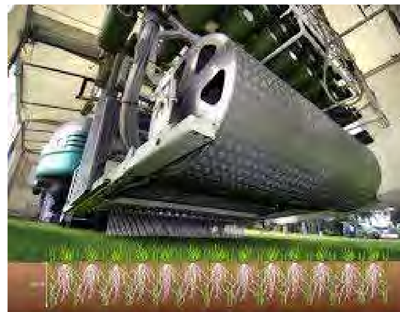
Rys. 16 Montaż trawy hybrydowej
