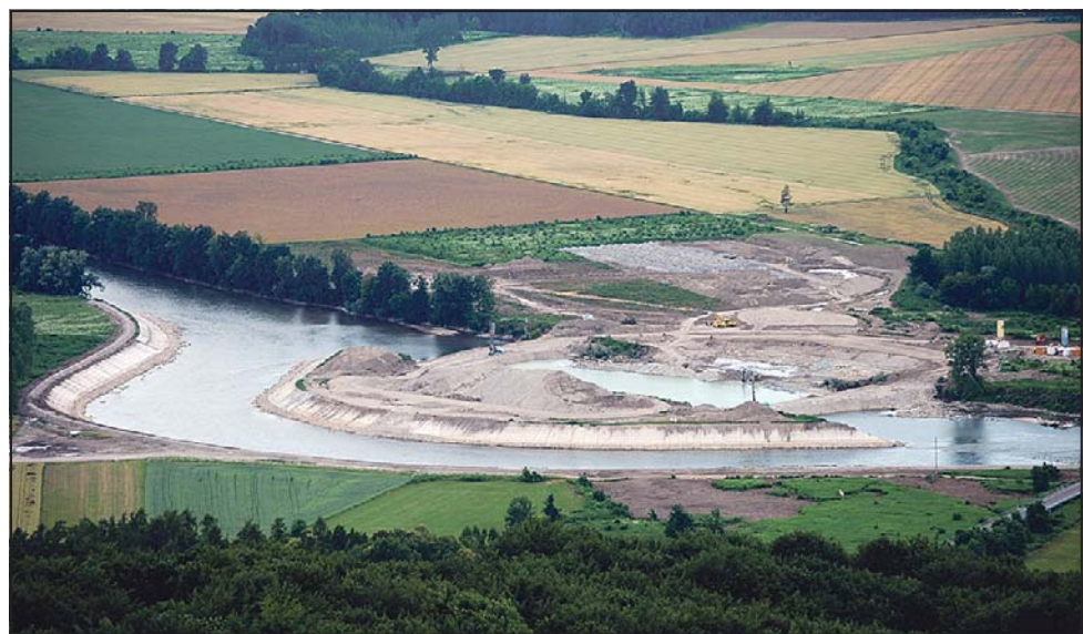
Pogled na gradbišče HE Brežice s Šentvida. Reka Sava je medtem že preusmerjena v obtočni kanal. (Foto: R. Retelj)
