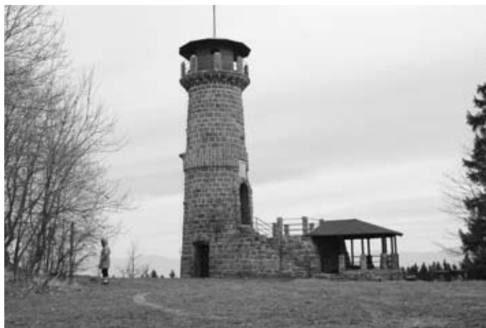
Wieża widokowa na Górze Wszystkich Świętych (widok obecny)
