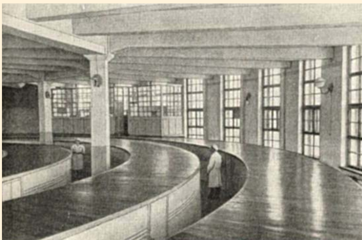
Закрытый конвейер хлебозавода
