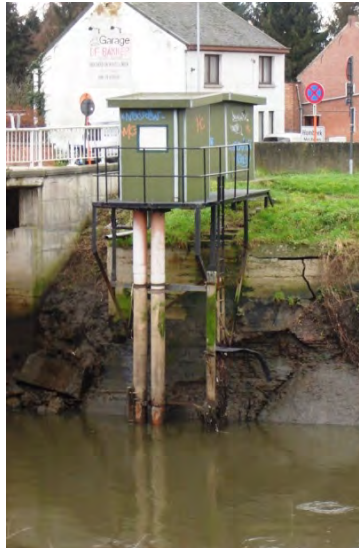
Figuur 37 - Tijdmeetinstallatie te Hombeek op de Zenne
