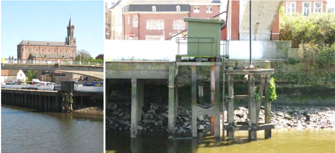
Figuur 21 - Tijmeetinstallatie te Wetteren op de Boven Zeeschelde.
