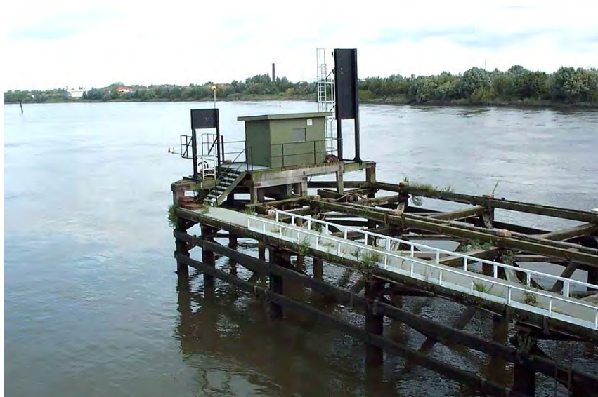
Figuur 26 - Tijdmeetinstallatie te Boom op de Rupel.
