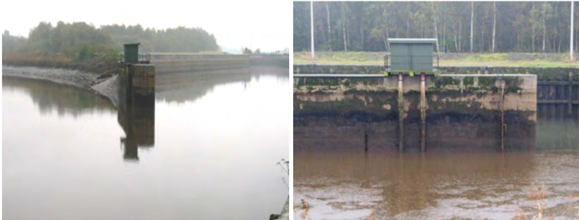
Figuur 28 - Tijmeetinstallatie te Duffel Sluis op de Beneden Nete.
