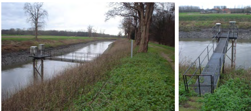
Figuur 38 - Tijdmeetinstallatie te Zemst op de Zenne
