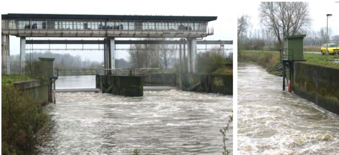
Figuur 25 - Tijmeetinstallatie te Zwijnaarde op de afleidings-tijarm Bovenschelde.
