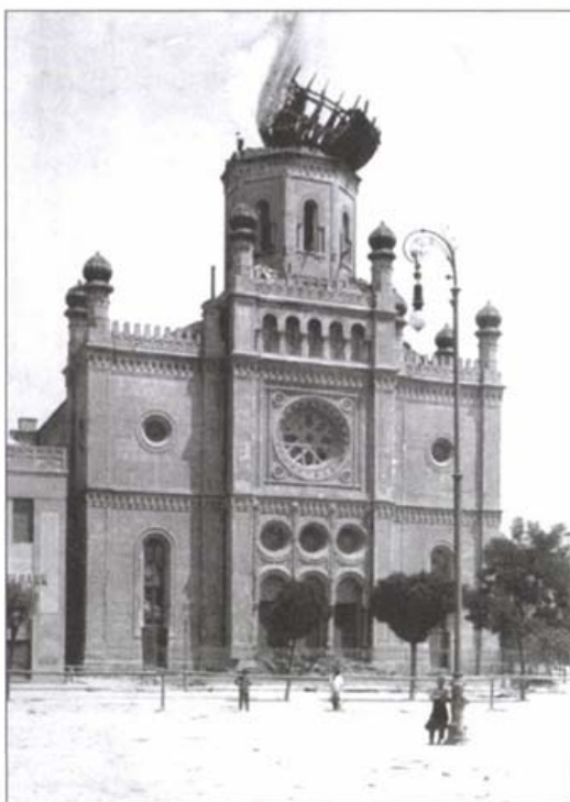
A zsinagóga a földrengés után
