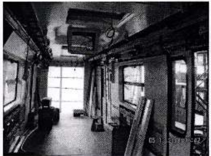
Fotografía 50. Instalación moldes de pantallas y ventiladores.
