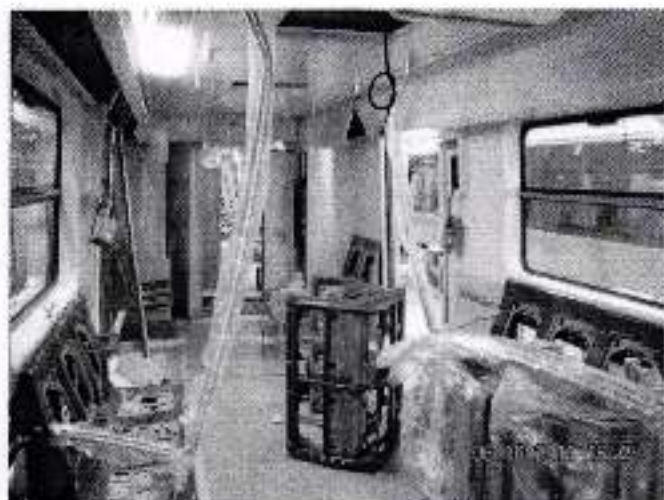
Fotografía 53. Instalación de asientos
