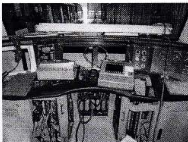
Fotografía 56. Instalación de equipo en cabina.
