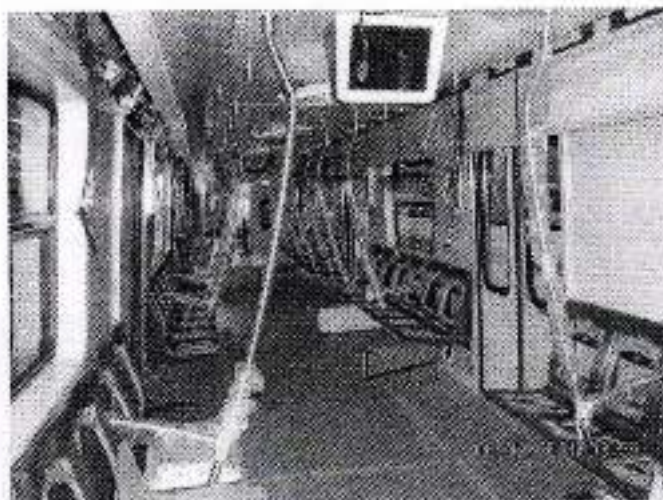
Fotografía 55. Colocación de pantallas.
