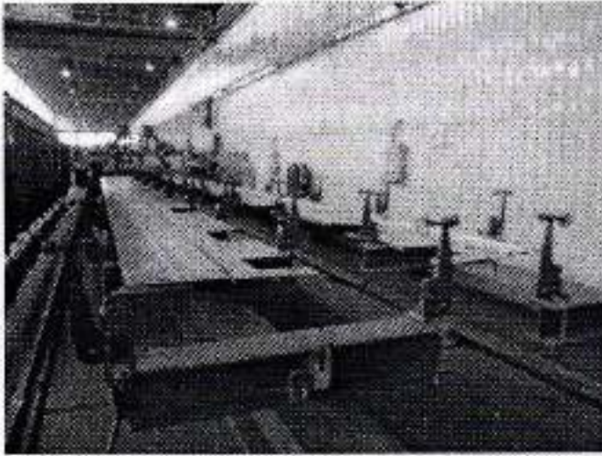
Fotografía 27. Ensamble de chapas de cubiertas.
