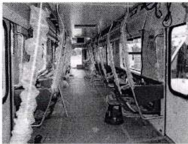
Fotografía 54. Colocación de tubos.
