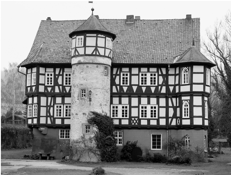
Hanstein'sches Rittergut/Schloss Werleshausen, zwischen 1556 und 1565 auf älterem Steinsockel errichtet
