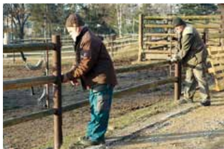
Truhláři při opravě ohrazení zubrů Joiners repairing the bison fencing
