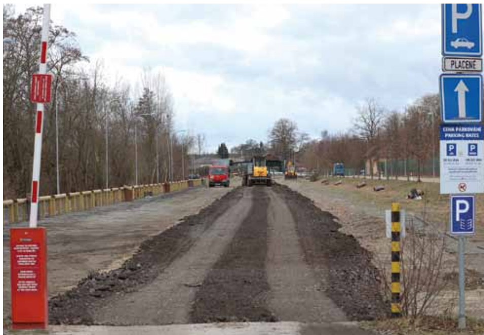
Rekonstrukce parkoviště Reconstruction of the parking place
