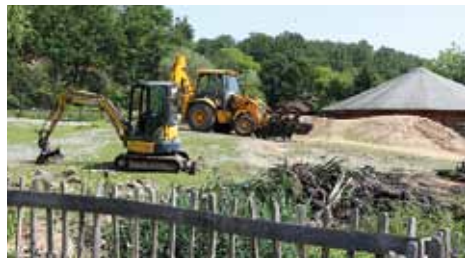
Úprava výběhu kulanů Reconstruction of the Kulan enclosure
