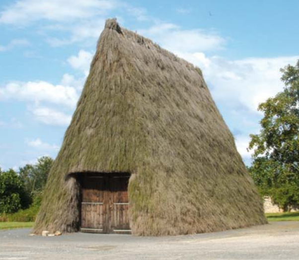
Le hangar en brandes à Bouresse.
