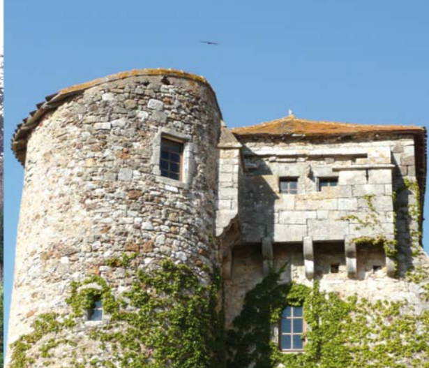
Tour de fortification de la Maison-Dieu à Montmorillon avec ses bretèches dans les parties hautes. Ces éléments permettaient de défendre les portes d'entrée de la tour.
