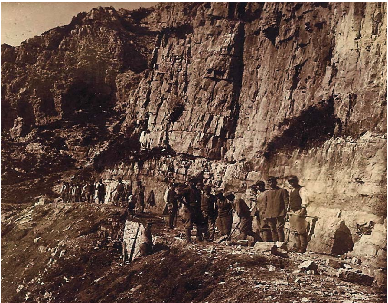
Forni Alti, Luglio 1917 – La strada di collegamento tra le gallerie è quasi terminata. Tortona, collezione privata.
