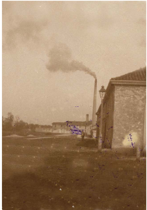
Il gazogeno, situato in fondo all'attuale piazza Milano, riforniva l'industria cittadina del gas necessario agli impianti di illuminazione.
