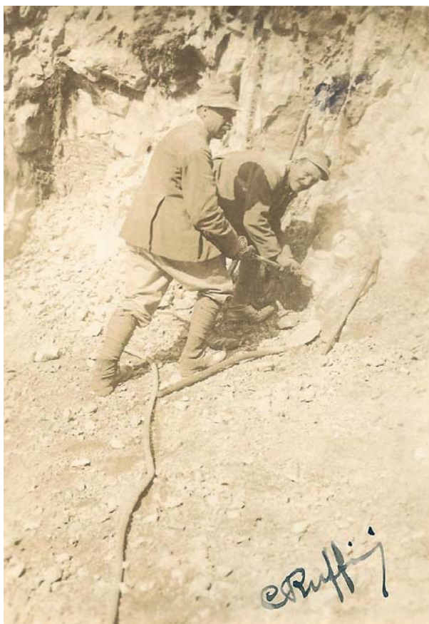
Forni Alti, luglio 1917 – I soldati spaccano la dura roccia armati di martelli perforatori. Tortona, collezione privata.
