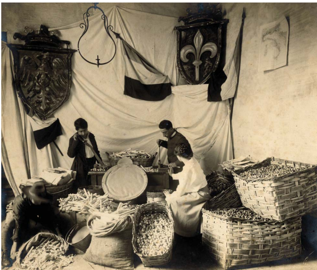
Il taglio dello Scaldarancio prima della spedizione ai militari al fronte. I rotolini di carta, imbevuti di paraffina, venivano accesi dai soldati in trincea per riscaldare la gavetta contenente il rancio. Tortona, Biblioteca Civica.
