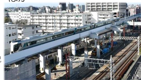
現在の竹ノ塚駅付近工事状況
