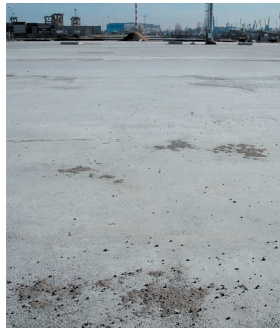
Площадки и проезды с покрытием «Денсифальт» на контейнерном терминале в Санкт-Петербурге на общей площади около 90 000 кв. м. Работы по его укладке были выполнены в сентябре — ноябре 2009 г. Фото: апрель 2010 г.
