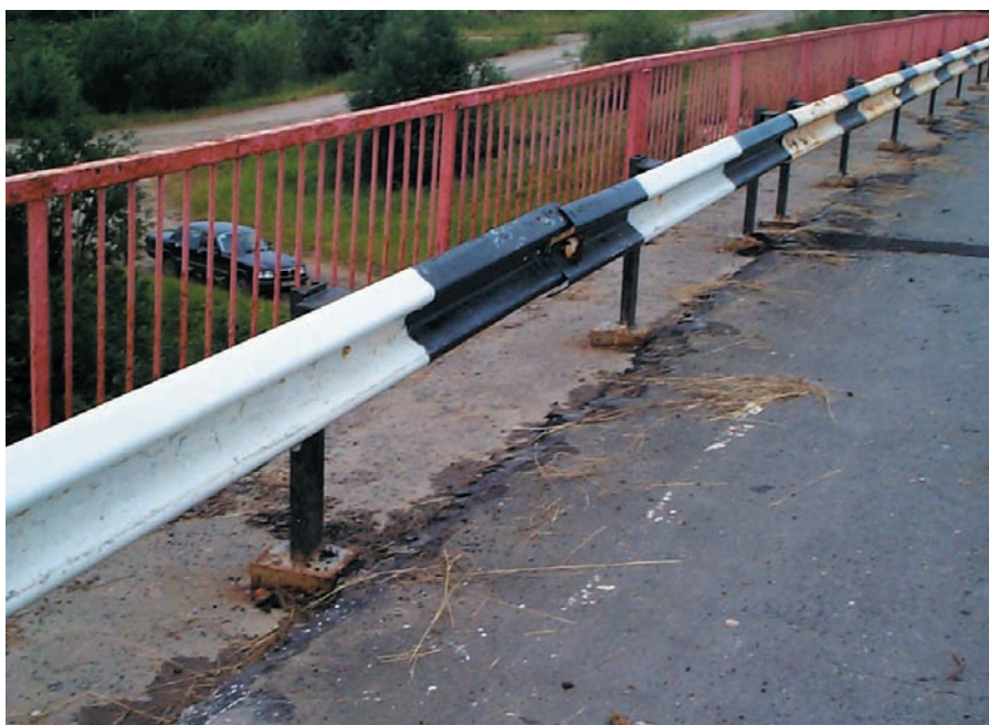
Рис. 2. Общий вид на проезжую часть деревожелезобетонного моста через р. Лявлю
