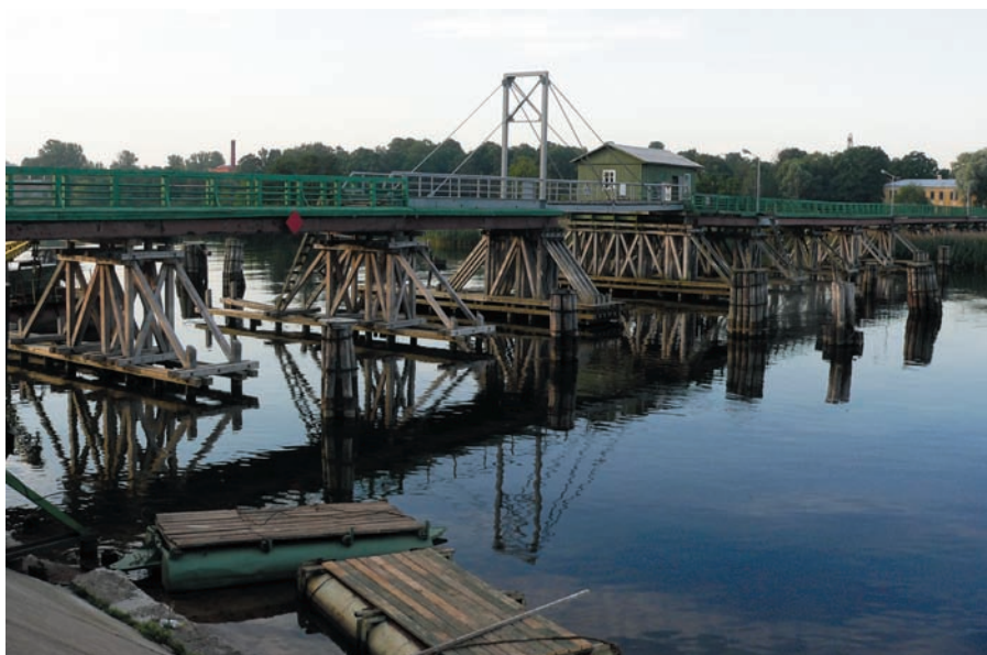
Большой Петровский мост через Малую Невку
