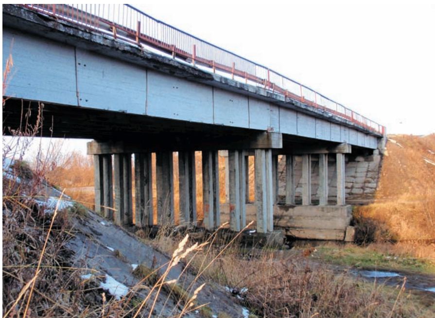
Рис. 1. Деревожелезобетонный балочный мост с пролетными строениями длиной 18 м под нагрузки А11 и НК-80 через р. Лявлю на автодороге Архангельск–М.Карелы–Пинега (год постройки 1991)
