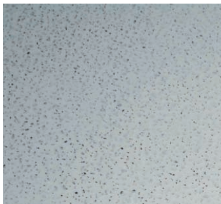
Финишная поверхность покрытия DENSIPHALT (территория контейнерного терминала, Санкт-Петербург, 2009 год)
