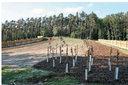
Рис. 6. Экодук в Чехии, дорога D11. Грунтовое покрытие, ограждения и посадки
