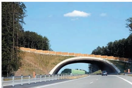
Рис. 5. Экодук в Чехии, дорога D11. Ограждение экодука выполнено в виде деревянных экранов
