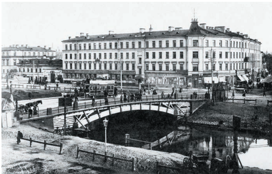
Деревянный Ново-Калинкин мост через Обводный канал
