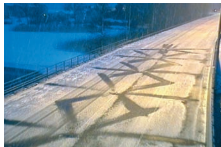
Мост в Раасепори, 28.03.2009. Слева — распыление антигололедной смеси (05.30 утра). Справа — колеса автомашин разбрасывают ее по мостовому покрытию (06.20 утра)
