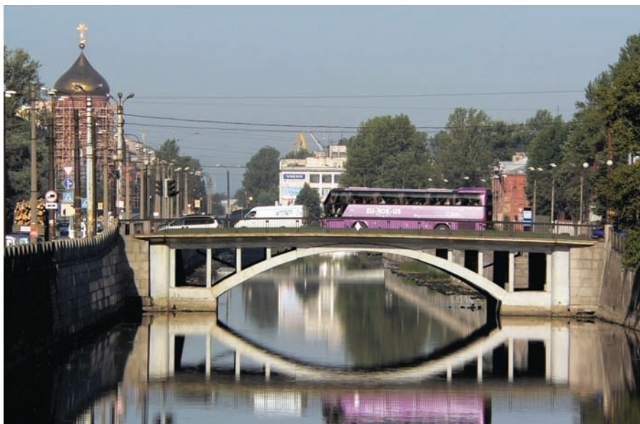
Железобетонный Ново-Калинкин мост через Обводный канал (перестроен в 1930 г.)
