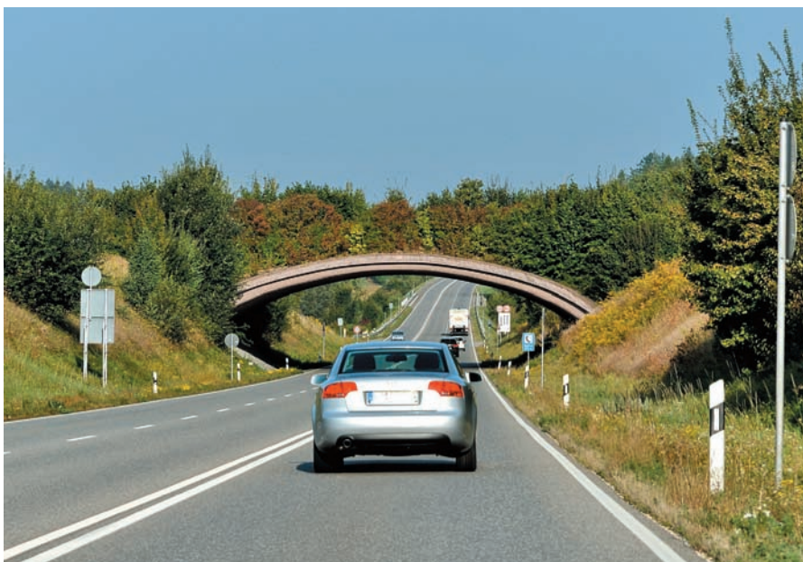
Рис. 3. Экодук. Ограждение выполнено в виде кустарника
