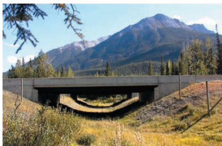
Рис. 8. Проход для животных в месте пересечения сухого лога. Канада
