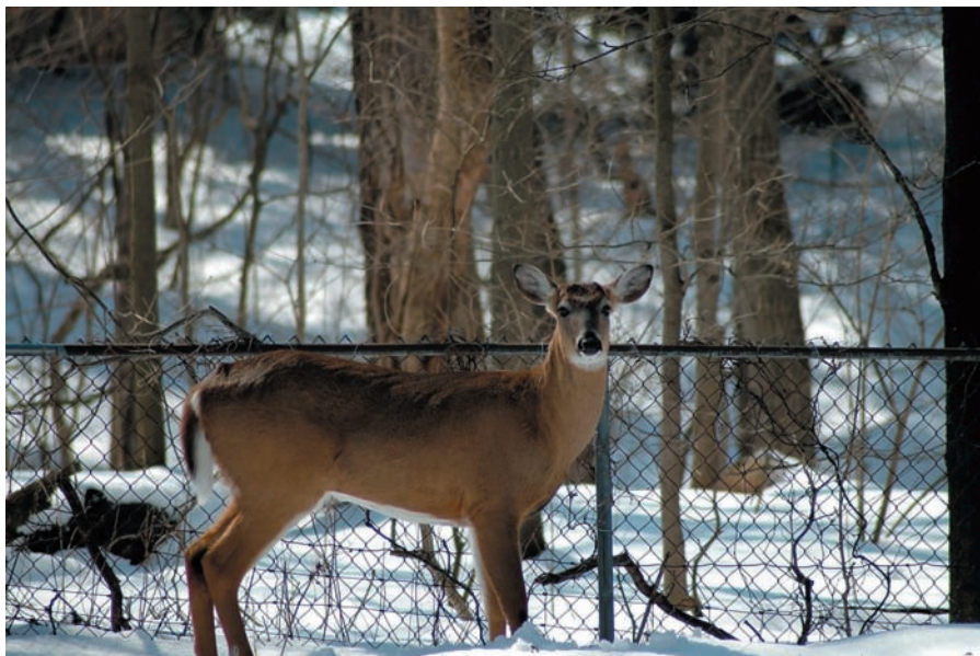
Рис. 1. Пример неверного подбора высоты сетчатого ограждения. Не учтено уменьшение высоты за счет снежного покрова
