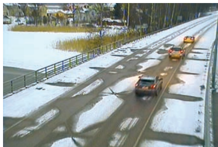
Мост в Раасепори, 28.03.2009. Слева — распыление антигололедной смеси (05.30 утра). Справа — колеса автомашин разбрасывают ее по мостовому покрытию (06.20 утра)
