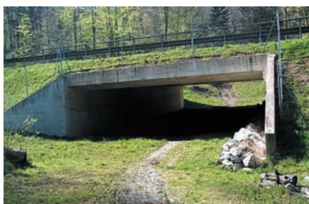
Рис. 7. Проход под дорогой для крупных животных. Дорога А1 в Швейцарии
