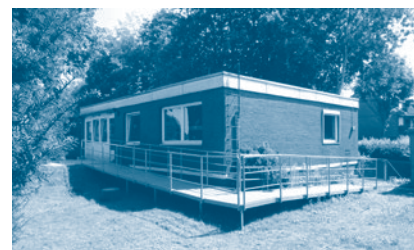
Nienburg: Barrierefreier Zugang zur ehemaligen Hausmeisterwohnung
