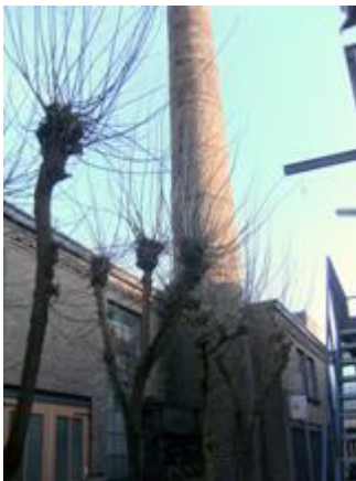
Het ketelhuis met schoorsteen van de leerlooierij van de Fa. Regouin. Te zien in het tuigleerstraatje. Beschermd monument.
