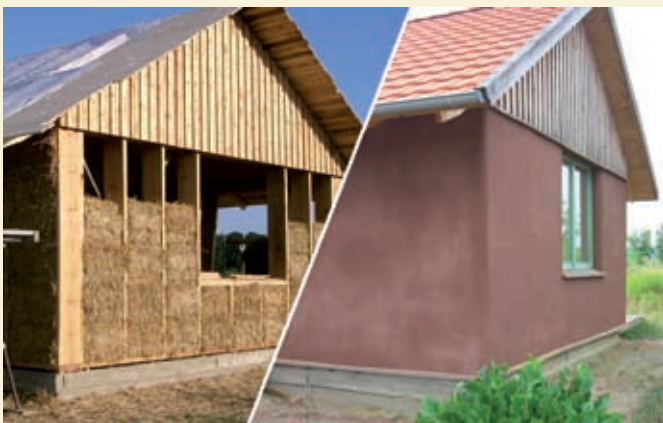
Häuser gebaut mit Strohballen – in Deutschland seit wenigen Jahren erprobt und zugelassen, in anderen Ländern bereits gang und gäbe. Bild: Dirk Scharmer
