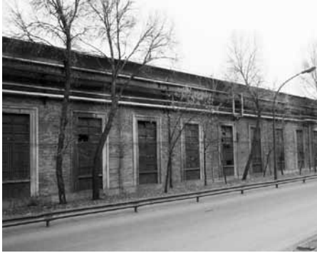
3. kép. A diósgyőri vasgyár 1950-es években épített középhengerművének a hengeres-tergá műhelye. (Jenei Lajos felvétele, 1997)
