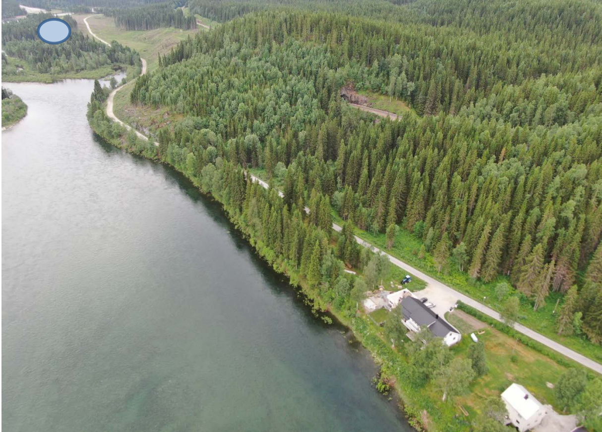
Oversiktsbilde over strekningen vist på bildene over, med ca. plassering av framtidig vegserviceområde på Vollen – som er regulert inn i E6 Svenningelv–Lien (Dronebilde Statens vegvesen)
