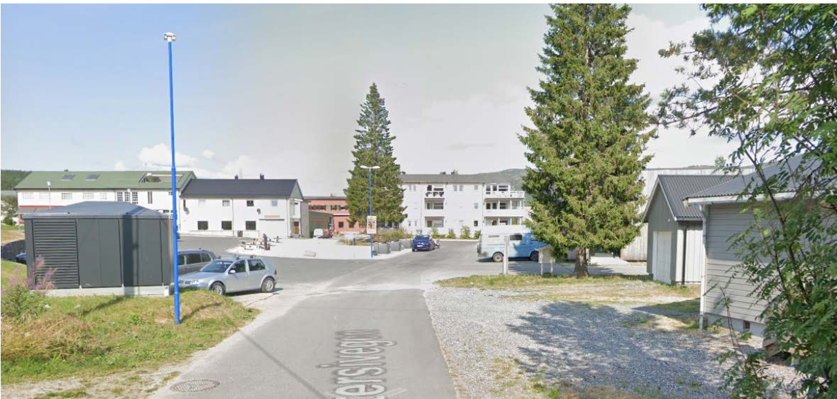
Ved det nye torget og foran Coop er det mye asfalt og grus og nokså udefinerte kjørbare flater. Belysningen har blå lysmaster (Googlemaps). Eksisterende avkjørsel og uteareal for Vestersivegen 2, gnr/bnr 50/89, på høyre side i forgrunnen
