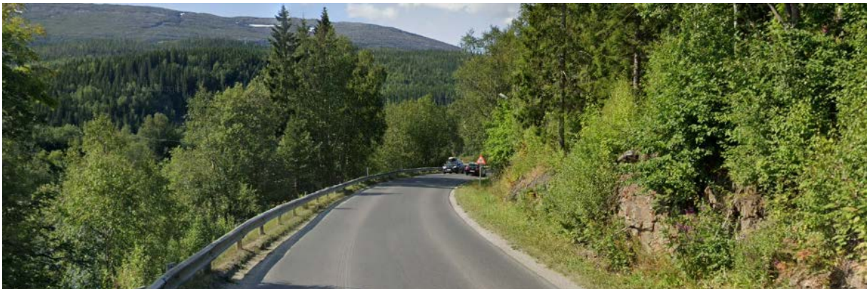
Fv. 803 på strekningen mellom Båfjellmo bru og Trofors bru. Skiltet hastighet 60km/t. Langt mellom lysstolpene
