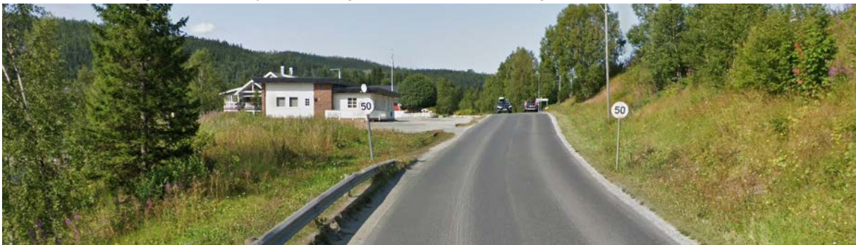
Farten på fv. 803 settes ned til 50 km/t når man nærmer seg kryss med Skolevegen, og Troforsen bru
