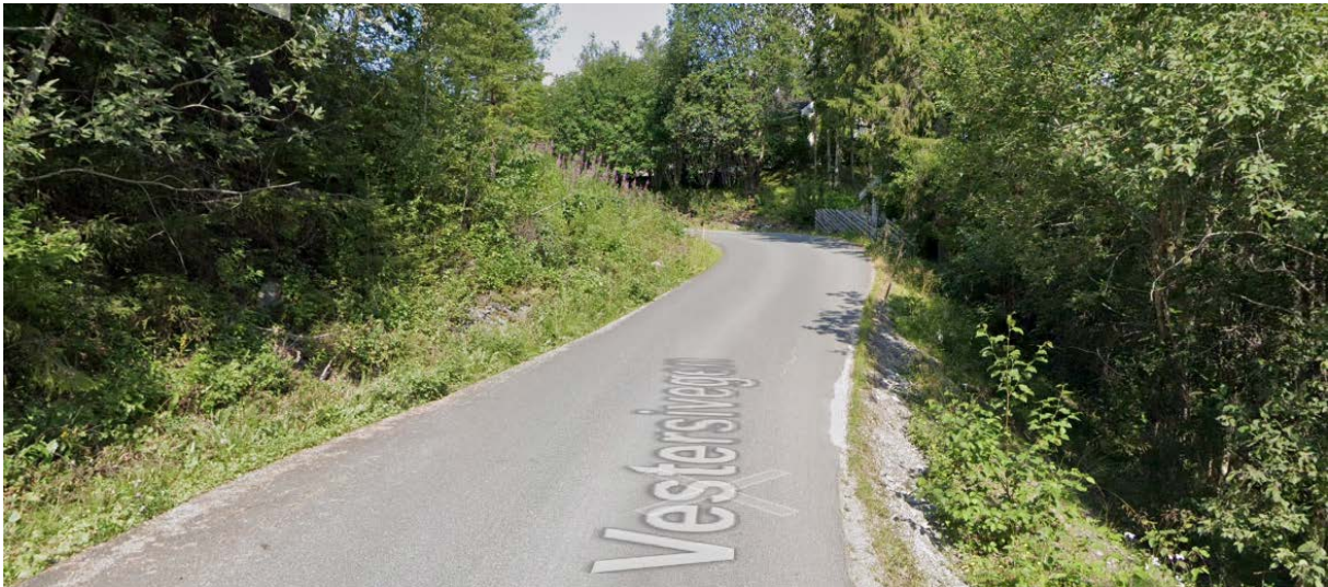
Svingen i oppstigningen gjennom boligfeltet har krevende kurvatur og lite sikt. Fortsatt er det ikke så lett å skjønne at man nærmer seg sentrum. Det er erosjonsutsatte masser i området. I sideterrenget er det lagt grov stein. (Googlemaps)
