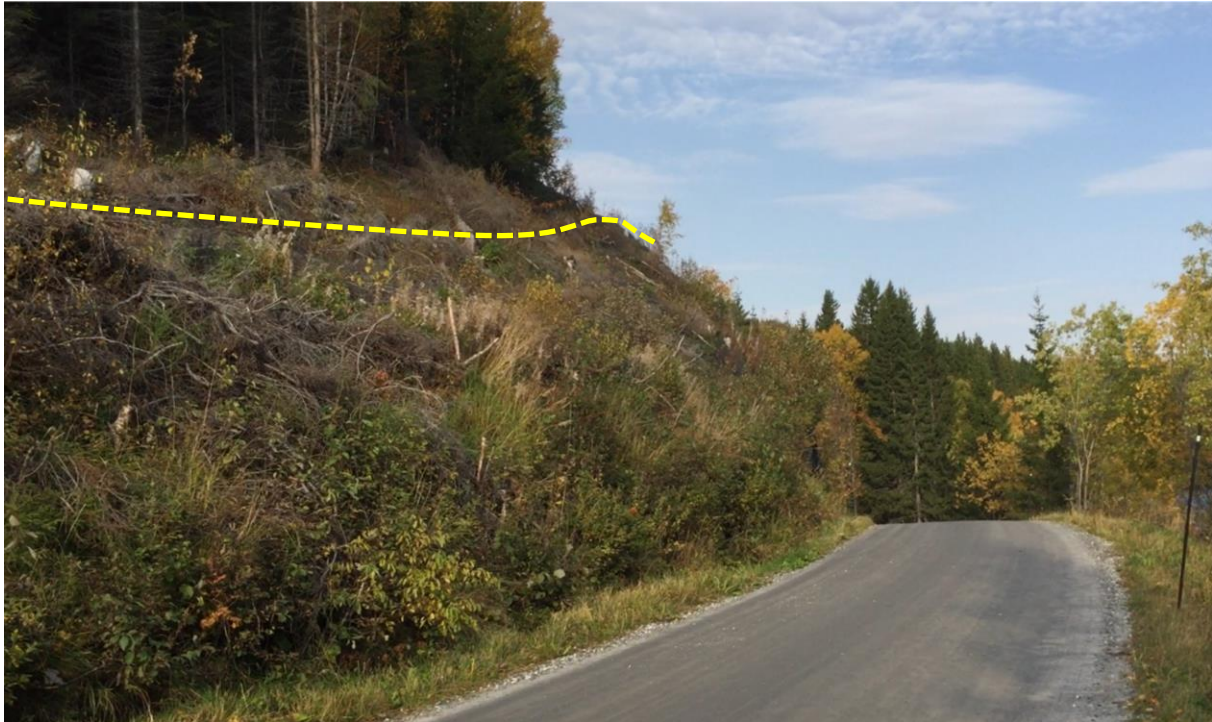
Figur 4: Nordre og høyeste parti av BS1 – her sett mot nordvest. Gul stipla linje angir ca. plassering av bergskjæringskant.
