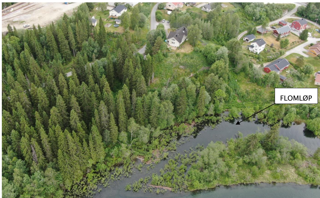
Bilde 3 – Området ved motfyllingen og flomløpet
