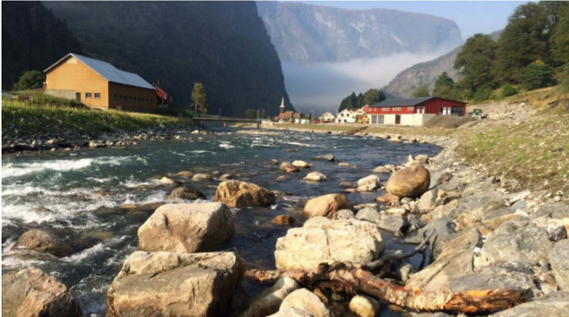
Eksempel på variert elvebredd etablert foran plastringsfot i Flåmselvi (Foto hentet fra Pulg, Stranzl, Olsen Mer miljøvennlige erosjonssikringstiltak Notat 3/2017)
