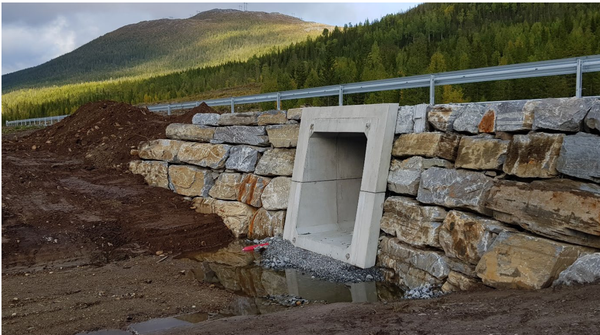
Eksempel på vellykket tilslutning mellom prefabrikert kulvert og tørrmur med naturstein fra anlegget. Også det på utbyggingsparsell E6 Kapskarmo-Svenningelv. Foto: SVV E6 Helgeland
