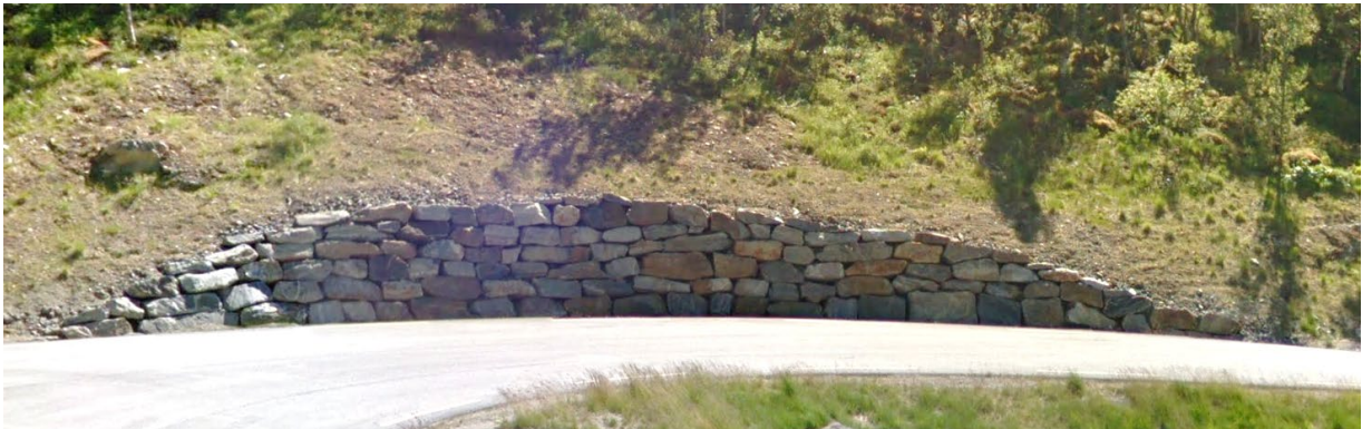
Eksempel på tørrmur med jevnt forløp i toppen. Foto fra E16 Googlemaps
