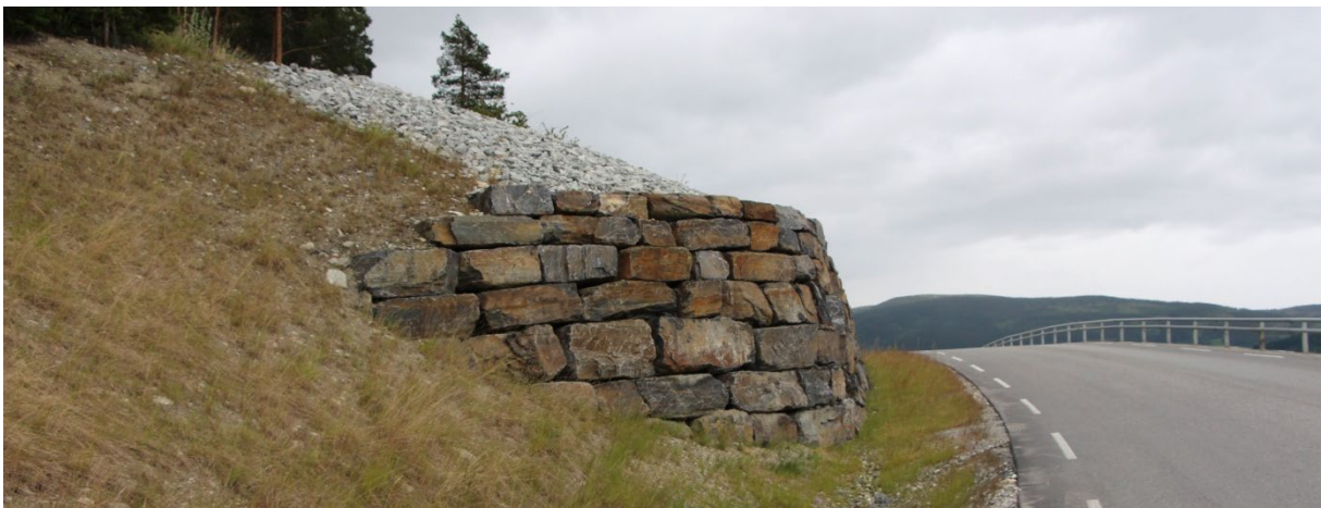
Eksempel på tørrmur langs lavtrafikkert veg, utsvingt og forankret inn i terrenget. Foto: E6 Biri-Otta
