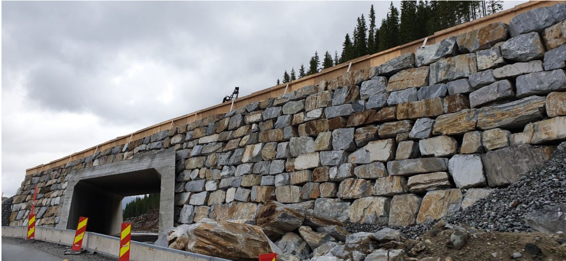
Tørrmuringen omkring kulverten på Svebakken er et eksempel til etterfølgelse på utbyggingsparsell Svenningelv-Lien. Foto: SVV E6 Helgeland
