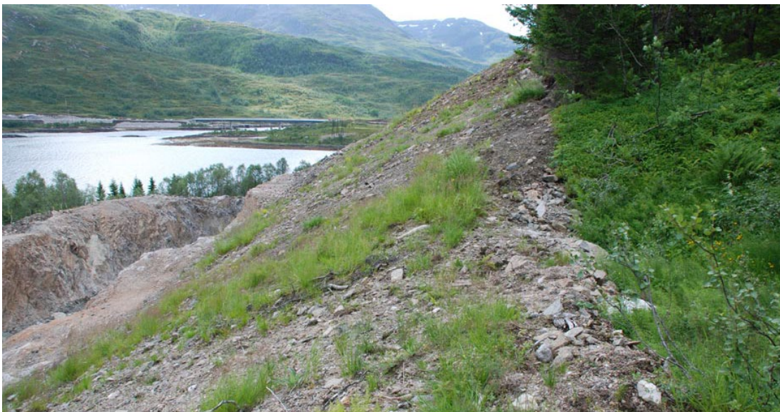
Erfaringsmessig må terrengtilpasning og utlegging av vegetasjonsdekke utføres i en direkte forlengelse av berguttak, og før man forlater topp bergskjæring (foto SVV fra E10 Lofast)
