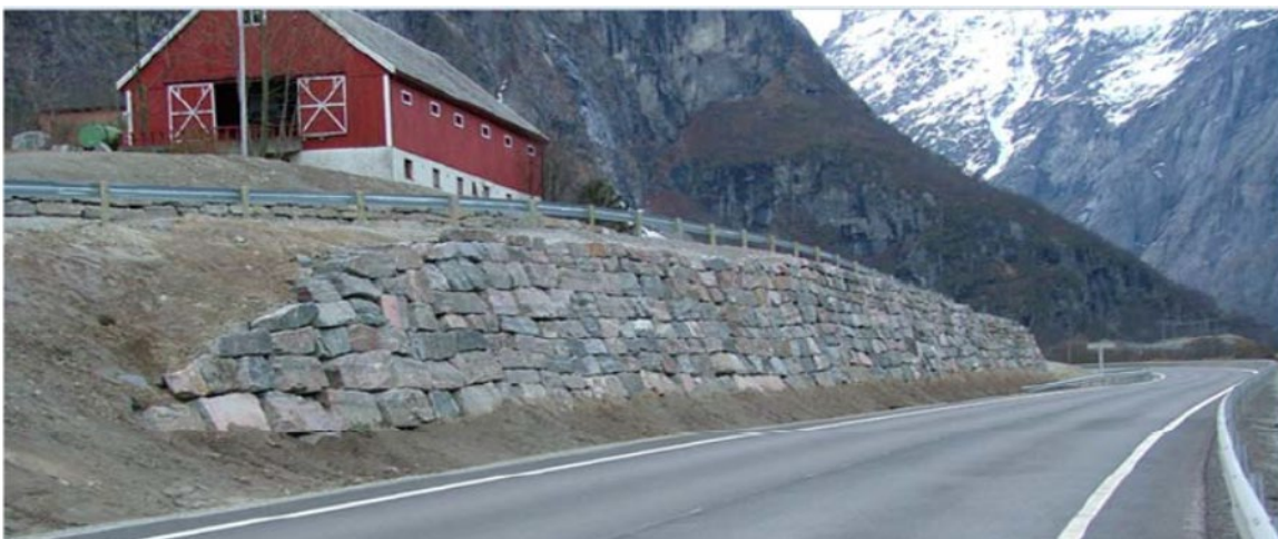
Eksempel på front mur med jevn lagtykkelse og linjeføring i lengderetningen. Foto Googlemaps
