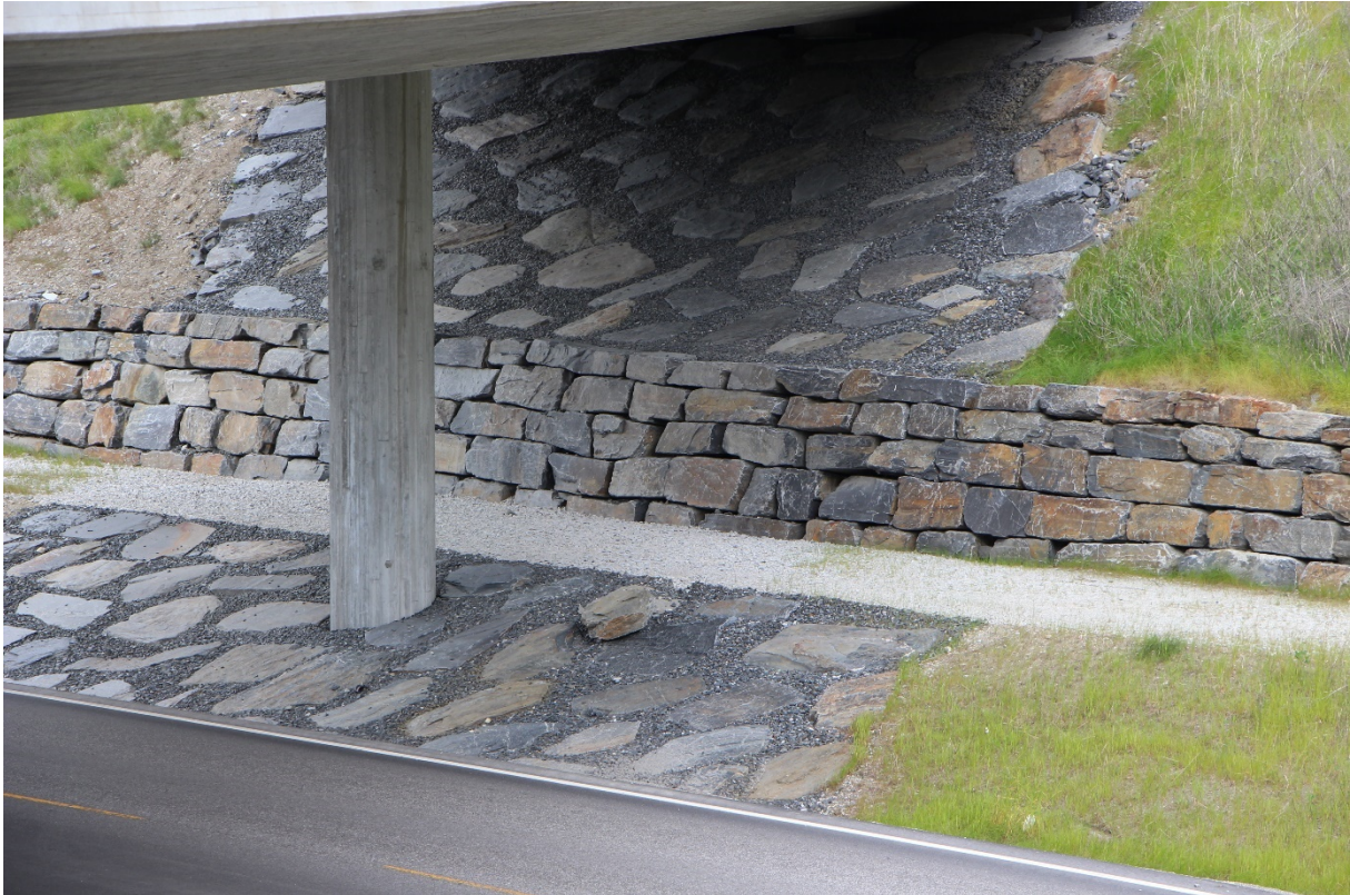
Eksempel på godt utført tørrmur og slettplastret dekke under bru. Foto: E6 Biri-Otta
