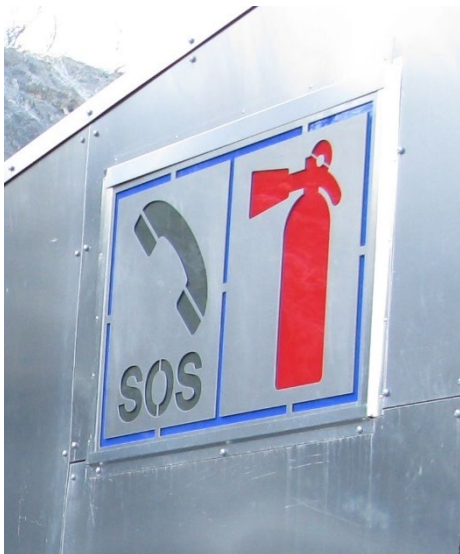
Eksempel fv. 17 Tverlandshalvøya: Nødskilt med integrert belysning i mørke innfelt i fasaden på teknisk bygg. Dette gir et rent og ryddig visuelt uttrykk
