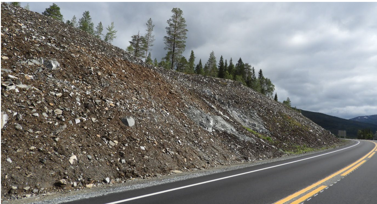
Eksempel på større bergskjæring utført som sprengsteinsskråning Foto: SVV E6 Helgeland sør
