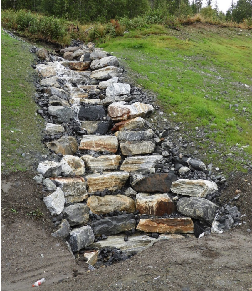
Eksempel på energidemping med ordnet, bratt murt nedløp. Foto: E6 Helgeland
