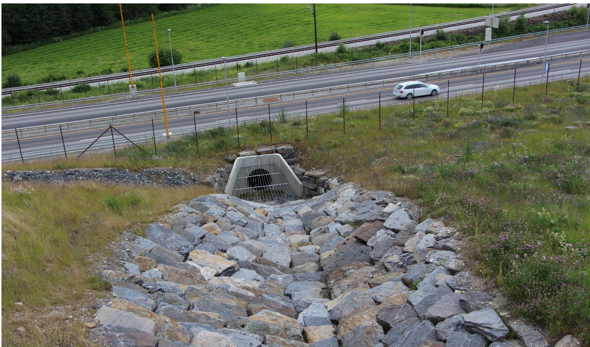
Eksempel på energidemping og bekkeinntak med innløpsrist. Foto: E6 Biri-Otta
