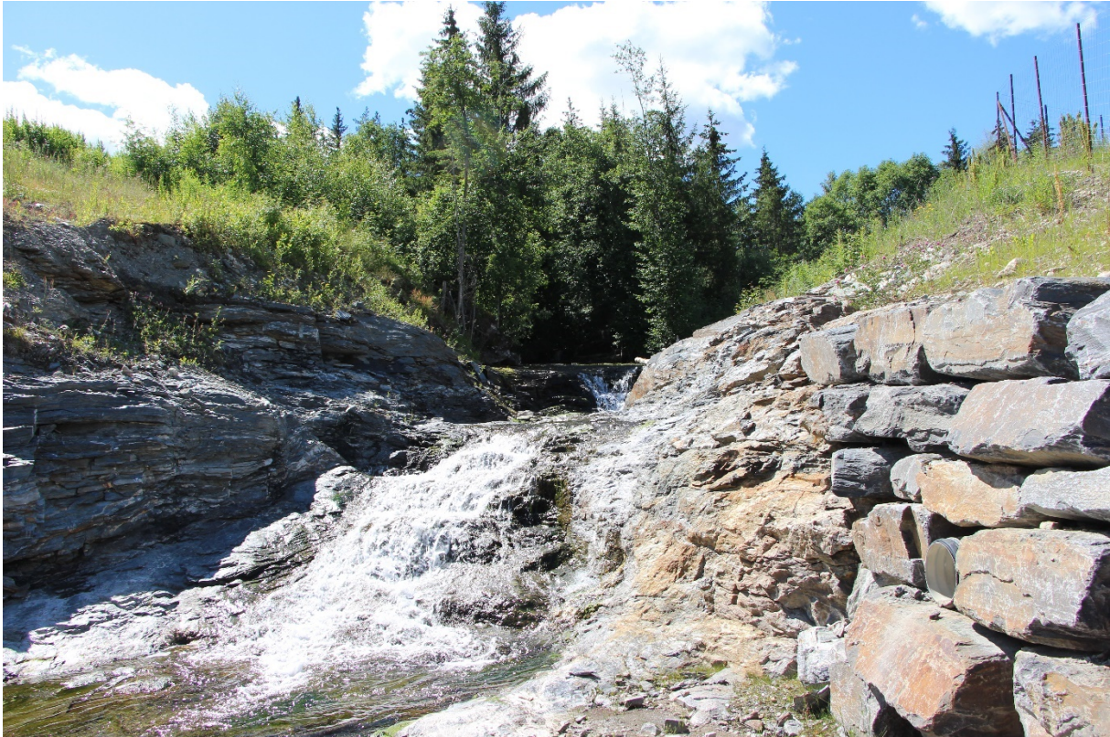
Eksempel på energidemping i nybygd bekkeløp i berg, der det er sprengt naturlike terskler i kombinasjon med mur. Foto: E6 Biri-Otta
