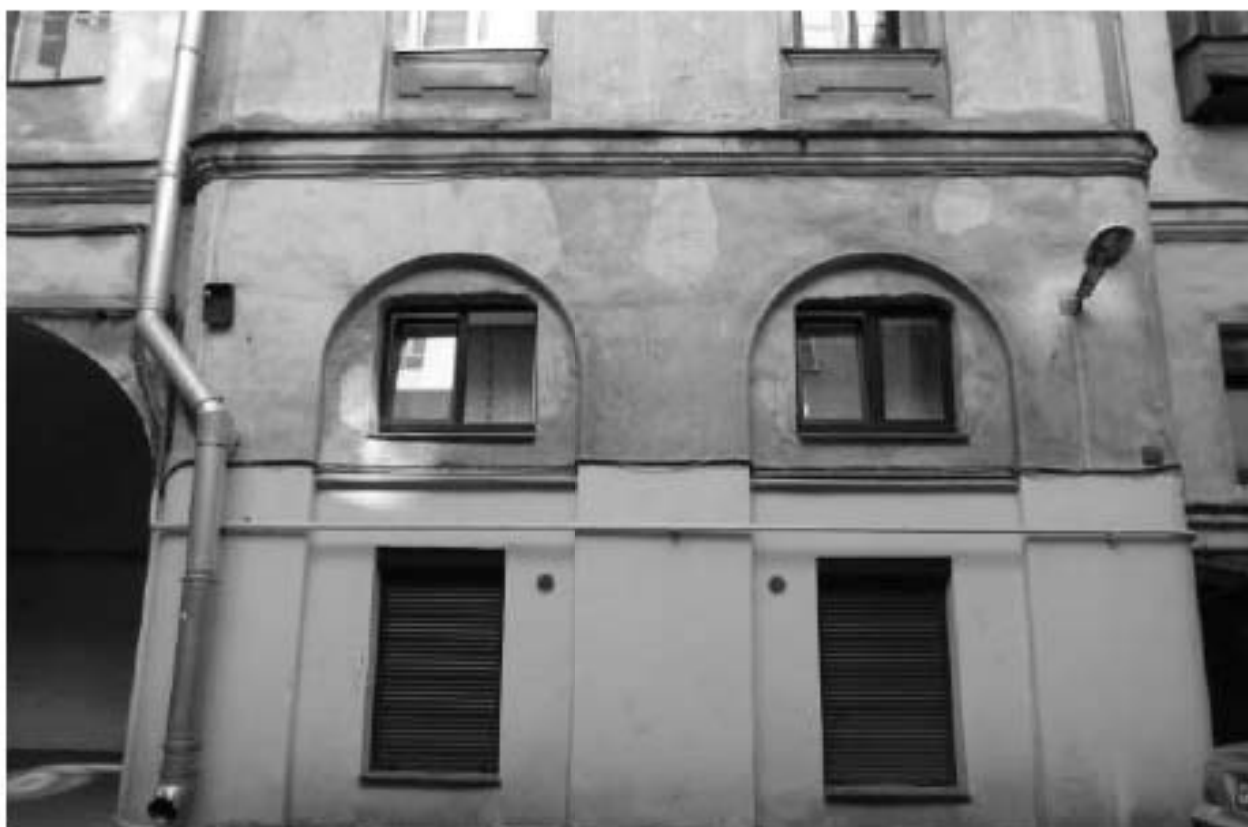
Фото 15. Фрагмент дворового фасада (05.12.2018 г.)
