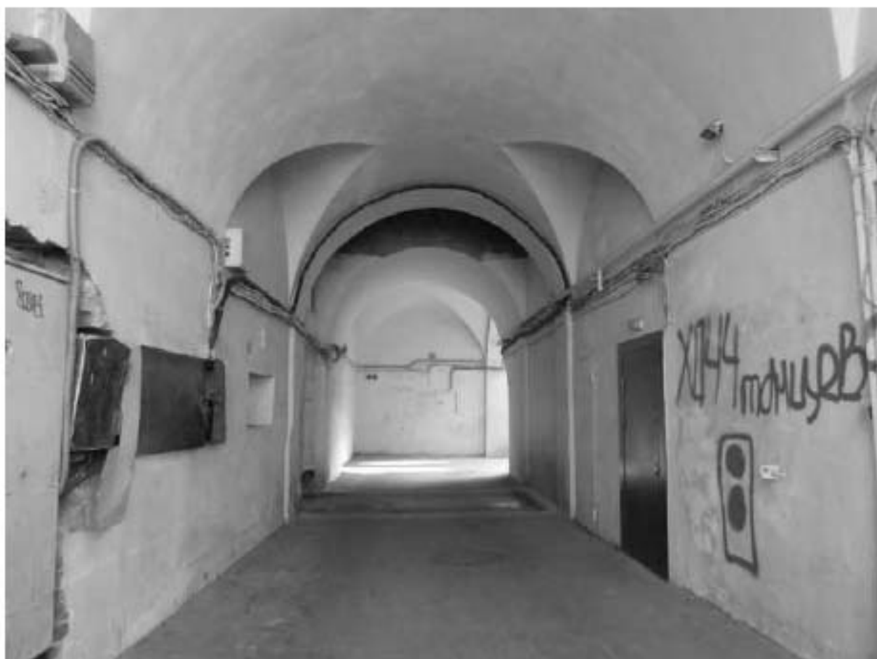
Фото 8. Фрагмент арочного проезда (05.12.2018 г.)
