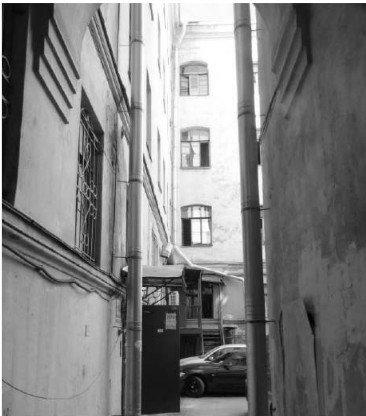
Фото 16. Фрагмент дворового фасада (05.12.2018 г.)
