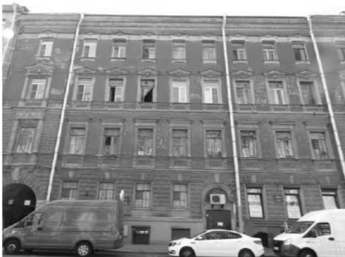
Фото 2. Общий вид лицевого фасада (05.12.2018 г.)
