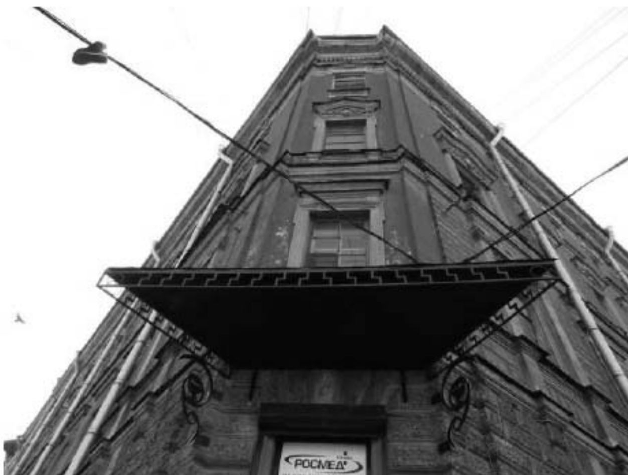
Фото 9. Общий вид углового фасада (05.12.2018 г.)
