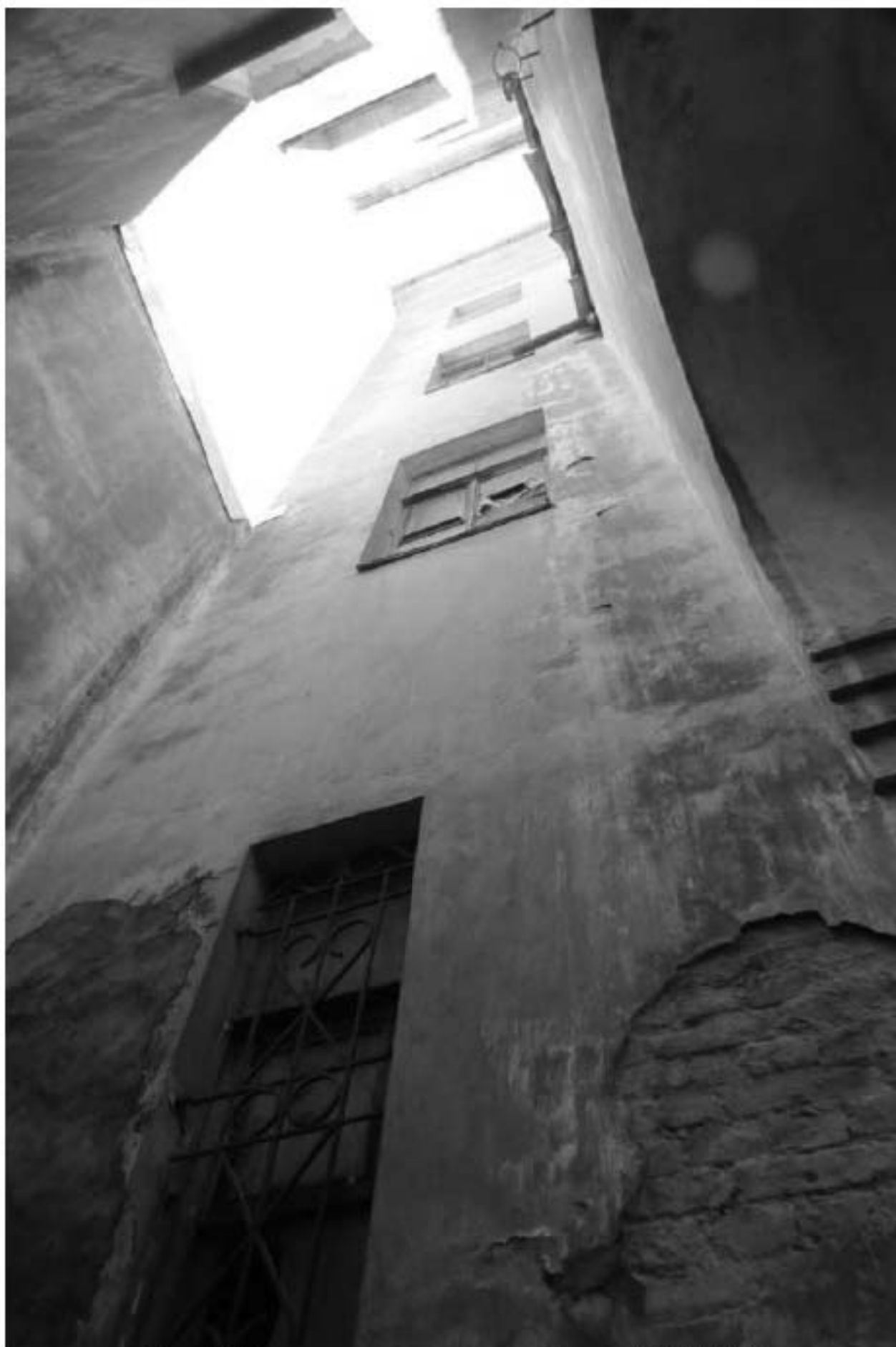
Фото 17. Фрагмент состояния дворового фасада (05.12.2018 г.)
