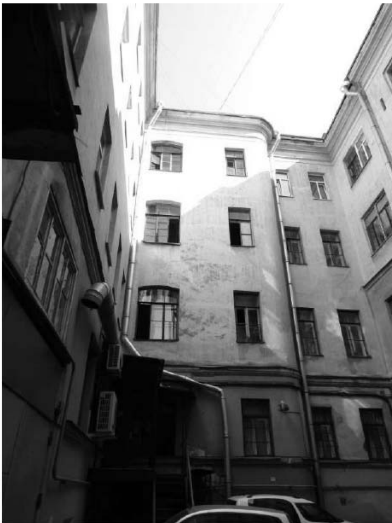
Фото 14. Общий вид дворового фасада (05.12.2018 г.)
