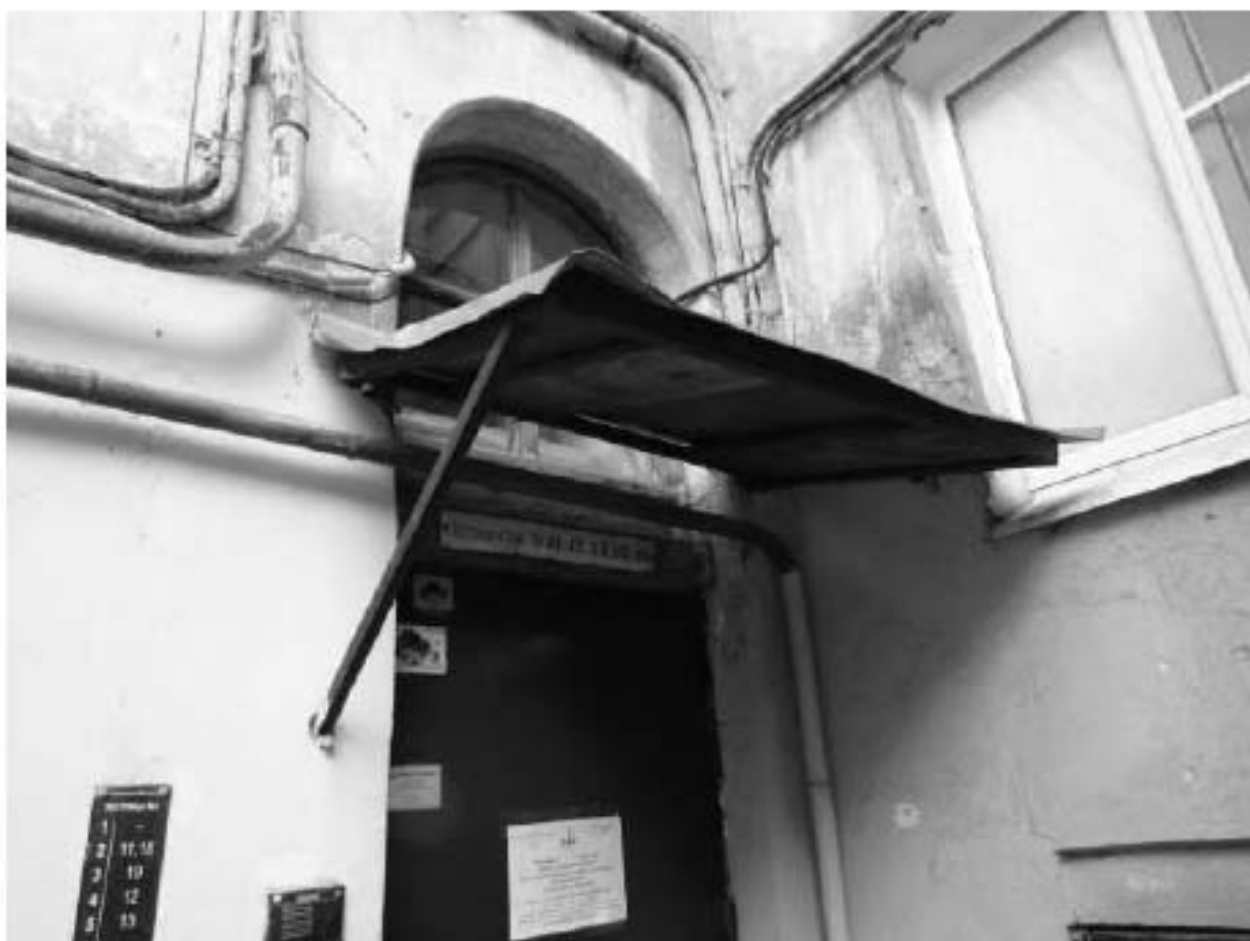
Фото 20. Фрагмент дворового фасада (05.12.2018 г.)
