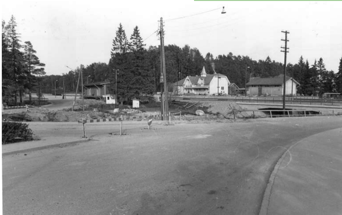
Rakennustyömaa: rautatien alittava tunneli, radan pohjoispuolinen liikenneympyrän alue ja eteläpuolinen Tunnelitie otettiin käyttöön 1965. Kuva rakennusvaiheesta.
