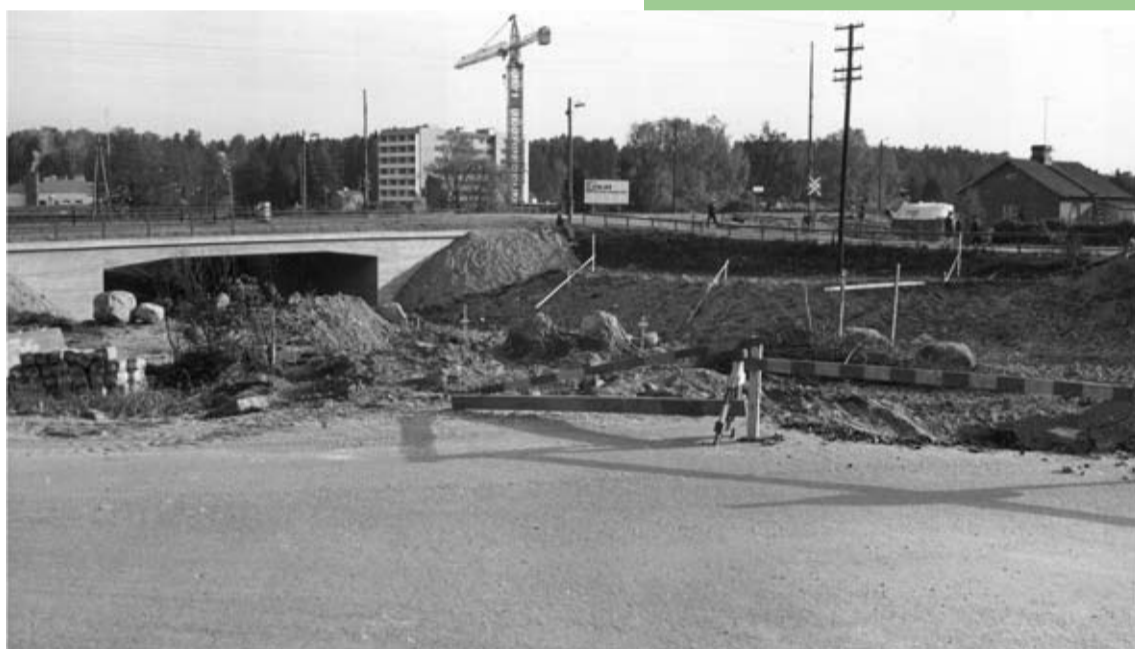
Rautatien alittava tunneli, radan pohjoispuolinen liikenneympyrän alue ja eteläpuolinen Tunnelitie otettiin käyttöön 1965. Kuva rakennusvaiheesta. Taustalla valmiina ns. Tornitalo.
