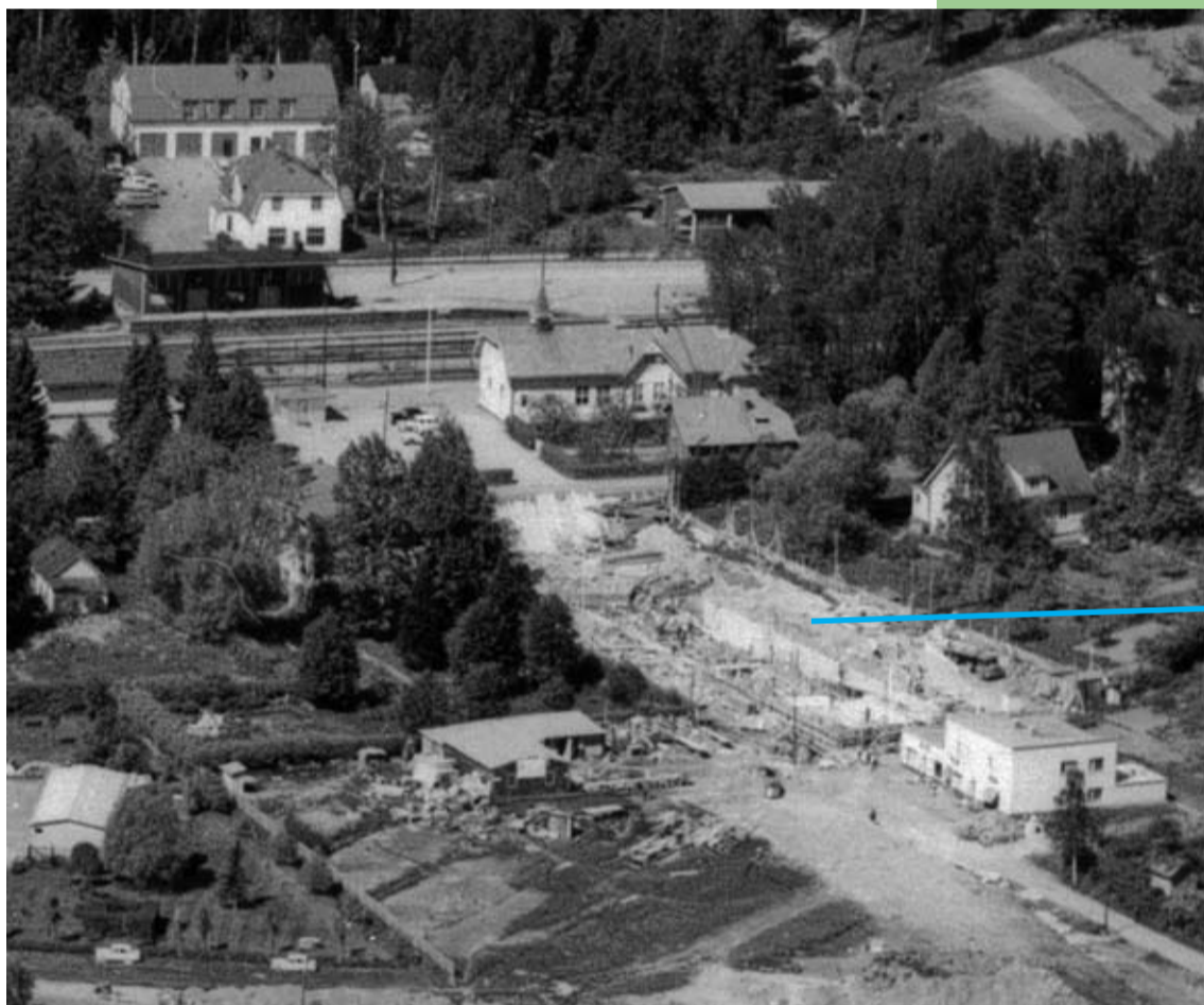
Keskellä Kauniaisten ensimmäisen asuinkerrostalon rakennustyömaa, Laaksotie 7. Talon liikesiipi valmistui jouluksi 1962 ja asunnot keväällä 1963. Vasemmalla ylhäällä R. Stenvallin kauppa ja sen takana autatalli-varastorakennus.
