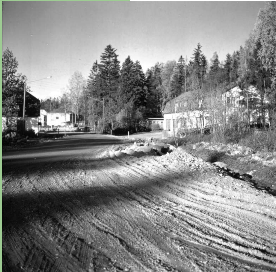
Helsingintien uuden linjauksen rakentaminen 1964. Tie halkaisi Stenvallin liiketontin, liiketalo vasemmalla. Oikealla varastorakennus, autotalli. Liiketalo puretti ja autotallin paikalla kerrostalo (Helsingintie 2). Taustalla Varubodenin talo.
