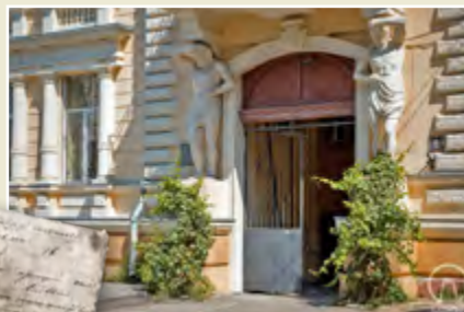
Фрагмент фасада дома Новикова
