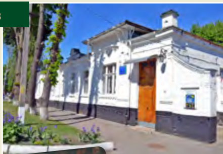
Будівля Лебединського художнього музею ім. Б.К. Руднєва
