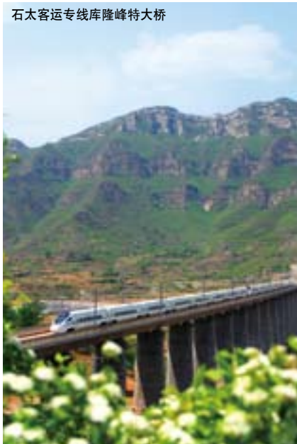
石太客运专线库隆峰特大桥
