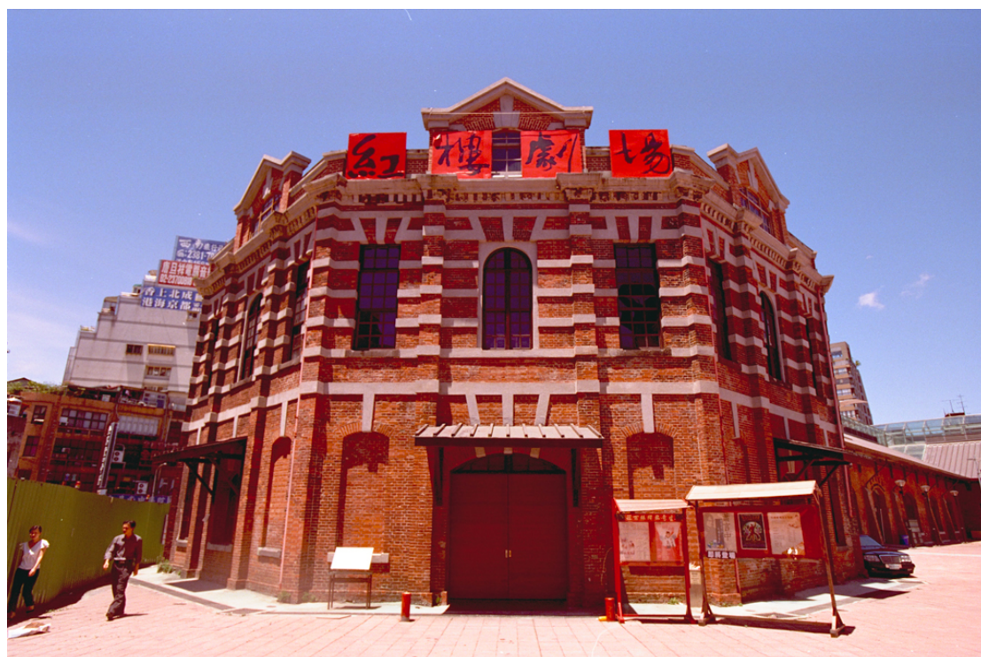
修復完工後的紅樓劇場樣貌（行政院新聞局典藏）
