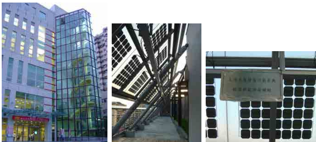
萬華區運動中心之建築外觀，以及其屋頂上所架設之太陽光電發電示範系統(高傳棋攝)
