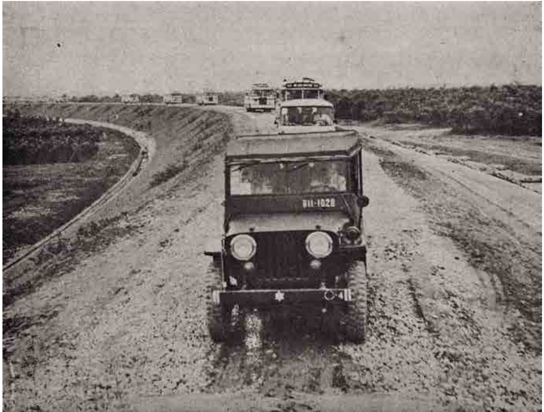
1960 年代雙園堤防之興建蒞影(高傳棋提供)
