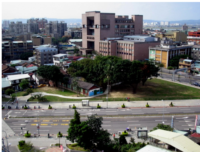
原位於西園路橋旁之仁濟療養院，除保留歷史建物外，其餘則闢建成綠地(高傳棋攝)
