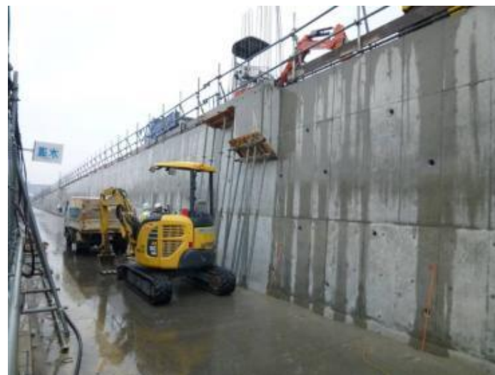
生活道路側から見た写真
