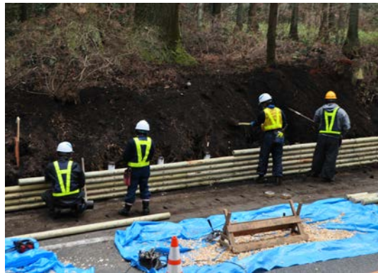
木柵改修状況
