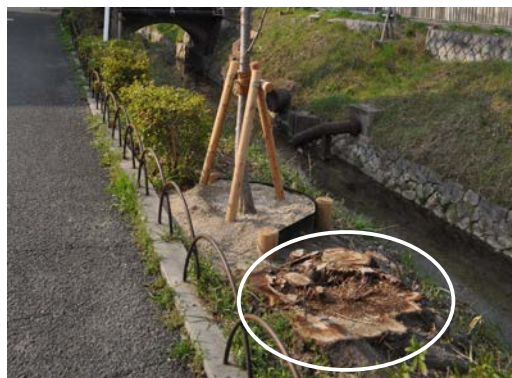
伐採木の腐朽状況（新規植栽木の横）
