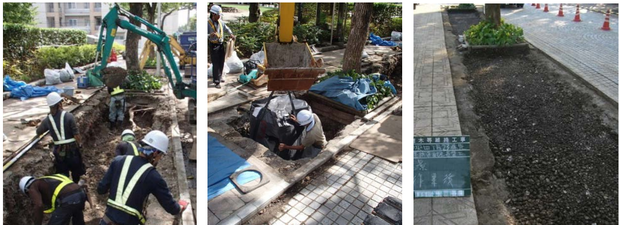
根系誘導耐圧基盤設置状況（左から、掘削 → 敷き均し → 転圧完了）
