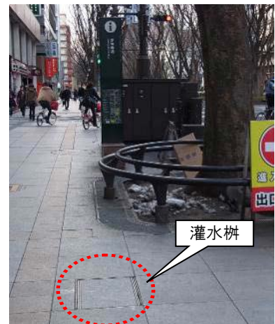
灌水柵の設置
