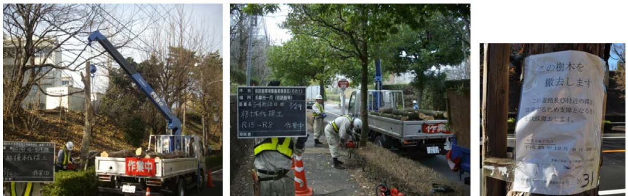
支障木の伐採状況
