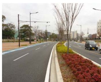
中央分離帯へのケヤキ植栽（地被植栽）
