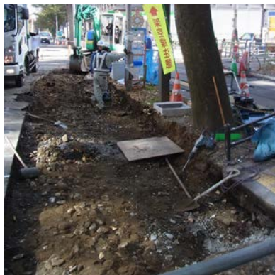
植栽基盤の改良状況
