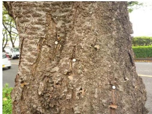
打込み式薬剤 施工痕
