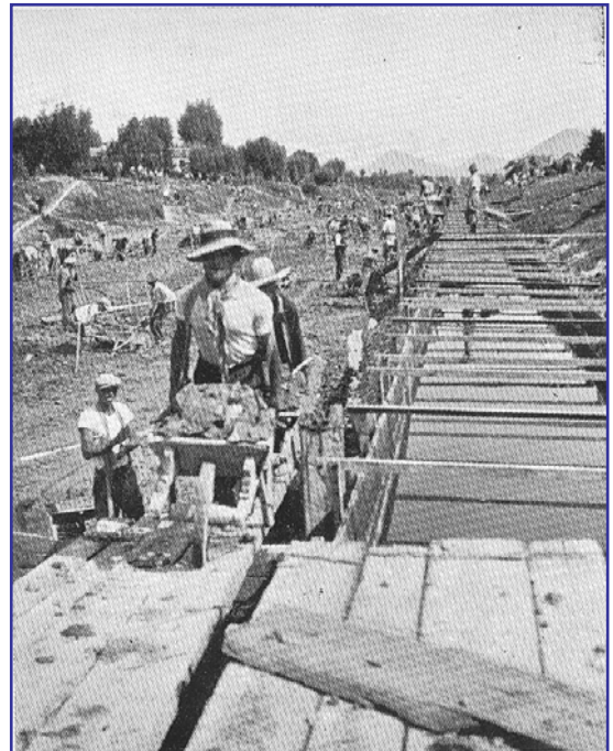
Lo scavo del collettore, con canaletta per deviazione dell'acqua (Consorzio Lozzo)
