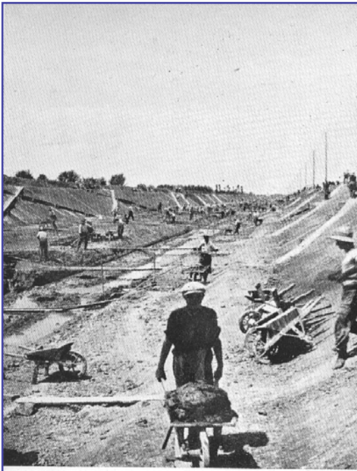
Lo scavo del collettore, con canaletta per deviazione dell'acqua (Consorzio Lozzo)
