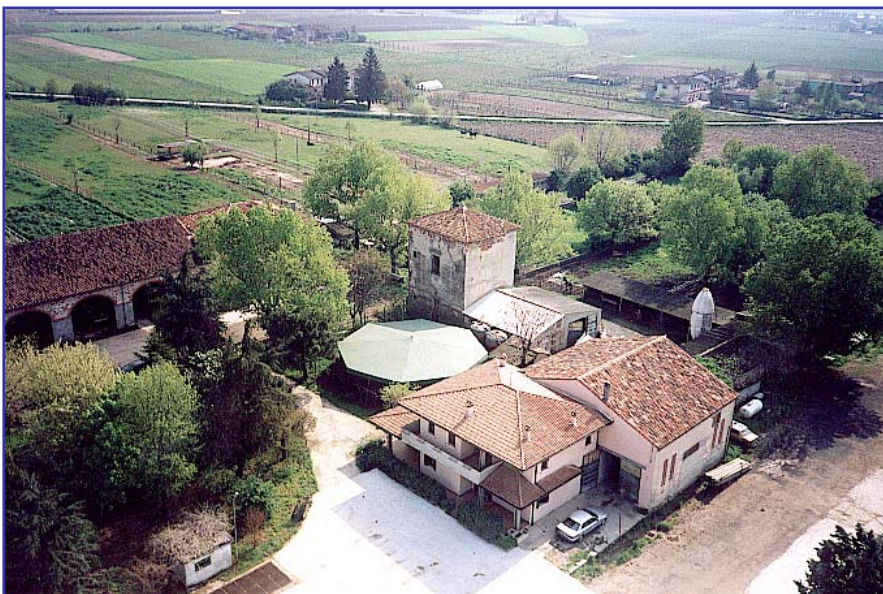
Veduta aerea della torre Muzzana
