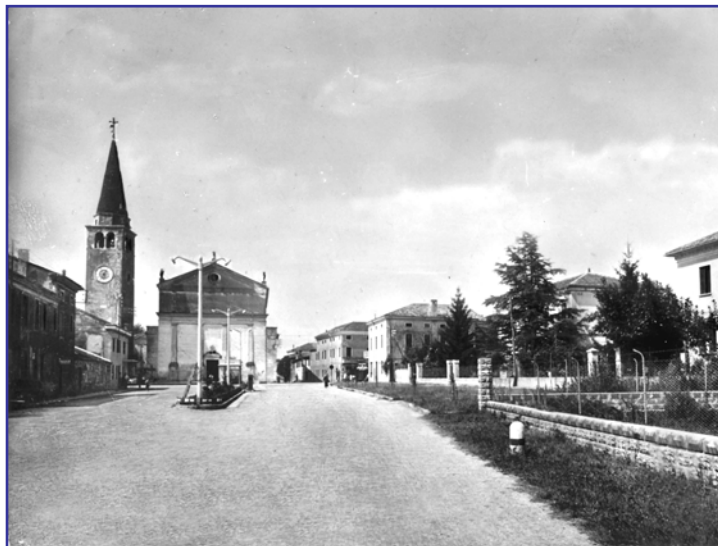
La chiesa vista da via Caldumare
