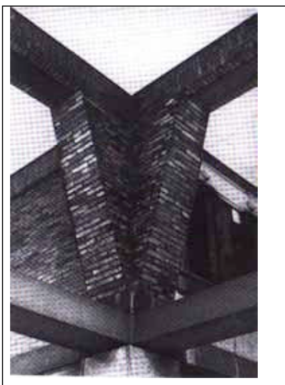
Uffici ENPAS dettaglio del pilastro
