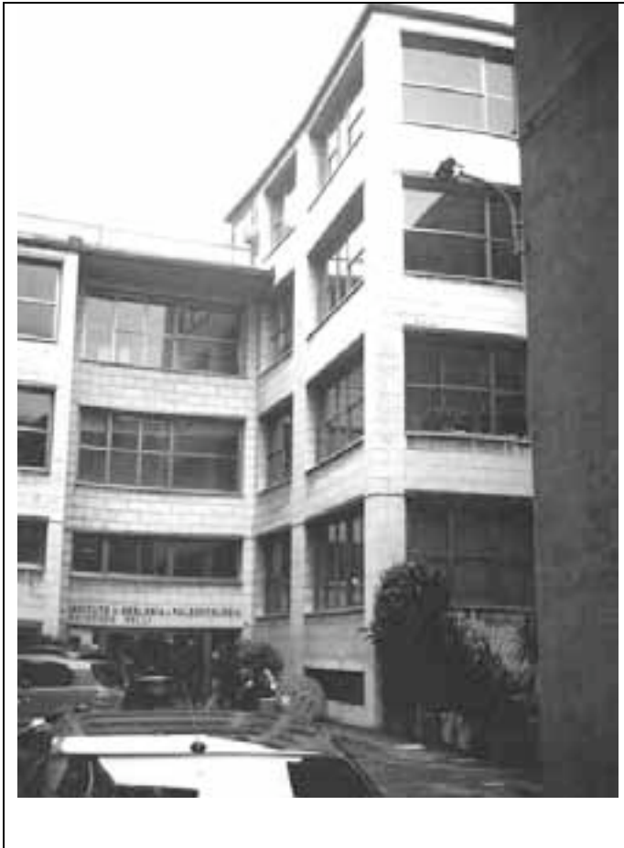
L'ingresso principale in una foto degli anni '70.
