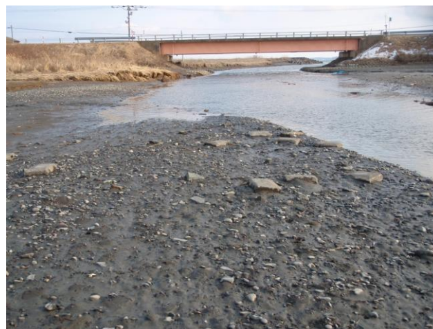
第1図 潮流三角州上に散乱したブロック（浜中町幌戸沼）
