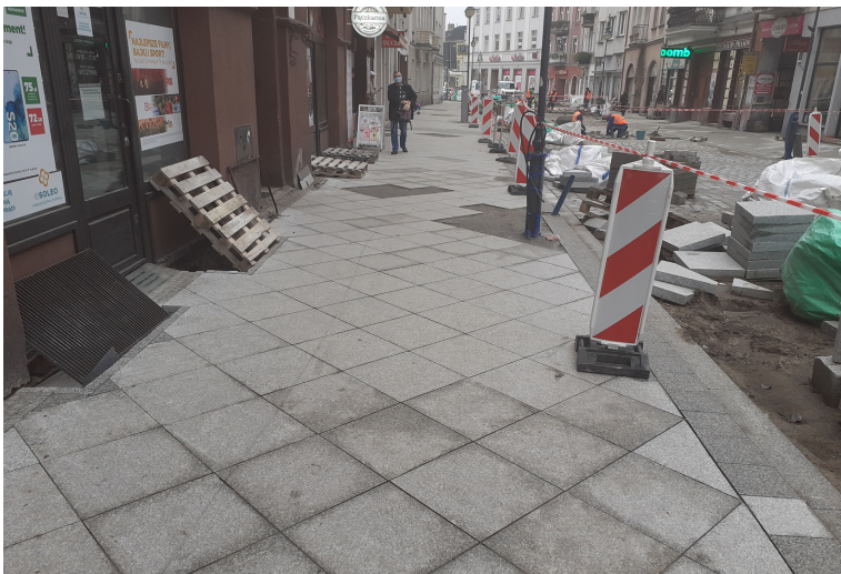
Fot. wymiana płyt chodnikowych, Kalisz, Arkadiusz Pacholski
