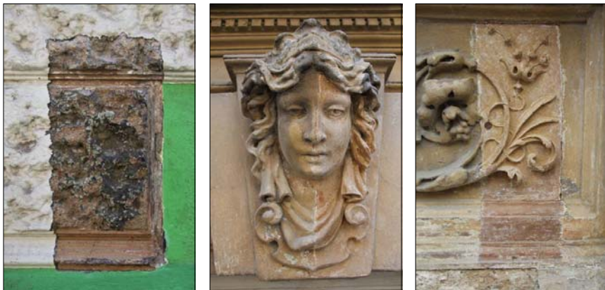
Obr. 5 Zkouška čištění parou
