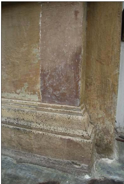
Obr. 4 Dva typy malt na bázi románského cementu
