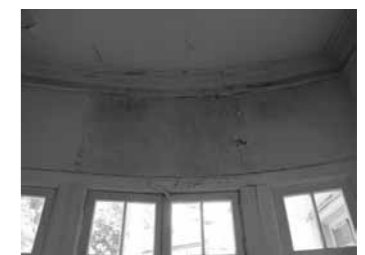
Foto 34a-b: Detalle de humedad en los muros de Londres 38 (J. Elizaga, 2011).
