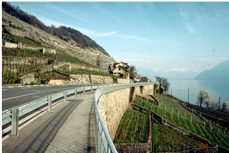
Treytorrens: murs de soutènement amont et aval Fig. 2 (nab, 4. 1. 2002)
