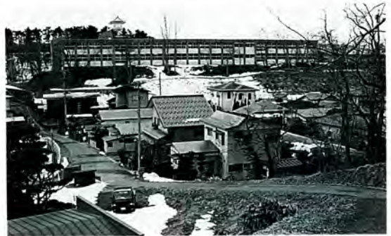
城内北の丸側からみた本丸方面の現在風景
