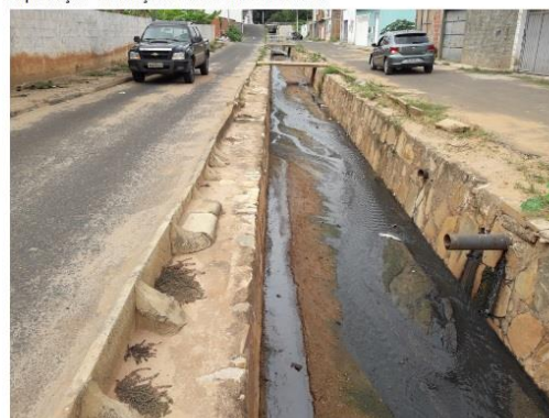
Retilnização e assoreamento no canal
