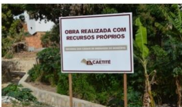
Obras de canalização de drenagens
