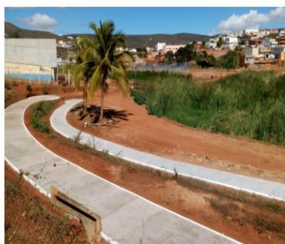
Construção do Parque Ecológico D. Paulo Jackson
