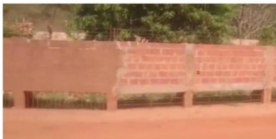
Rio São João (construção no leito do rio) - Bariro Pisco Viana
