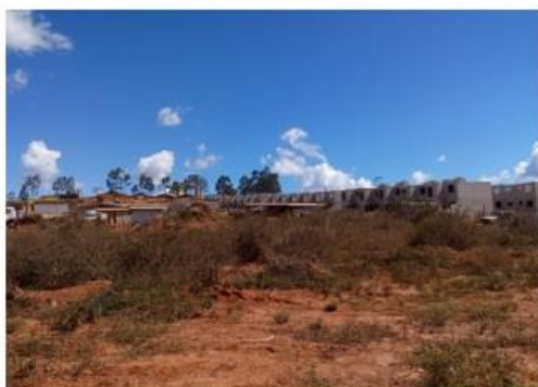
Obras do Condomínio Esmeralda
