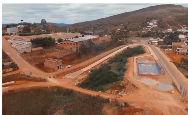
Galpões da Fábrica Fortiori (à esquerda) - Construção do Parque Ecológico (à direita) - 2018
