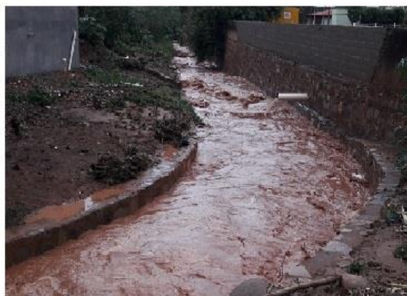
Riacho Pedreiras 2017, pós canalização
