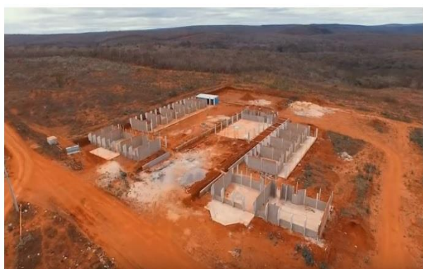
Construção do Centro Administrativo de Caetité (CAC) - 2016
