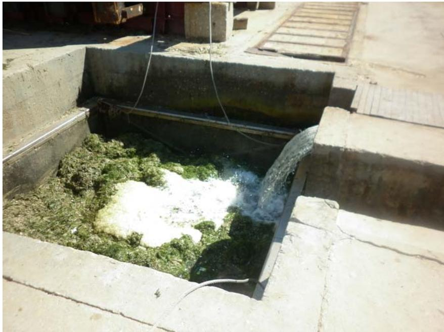
**Figure 46: sédiments, algues etc. retenus dans les grilles de la station de pompage**
