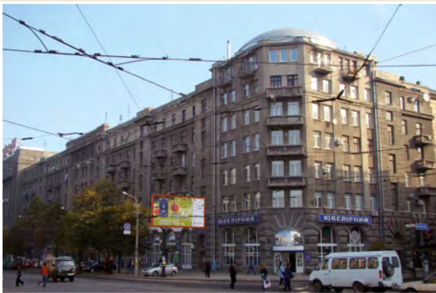
Жилой дом (литерный) (вид со стороны ул. Полтавский шлях) Бывший «Дом Южных Ж.Д.» ул. Красноармейская, 8/10 1925 — 1936 гг. Авт. А.Н. Бекетов
