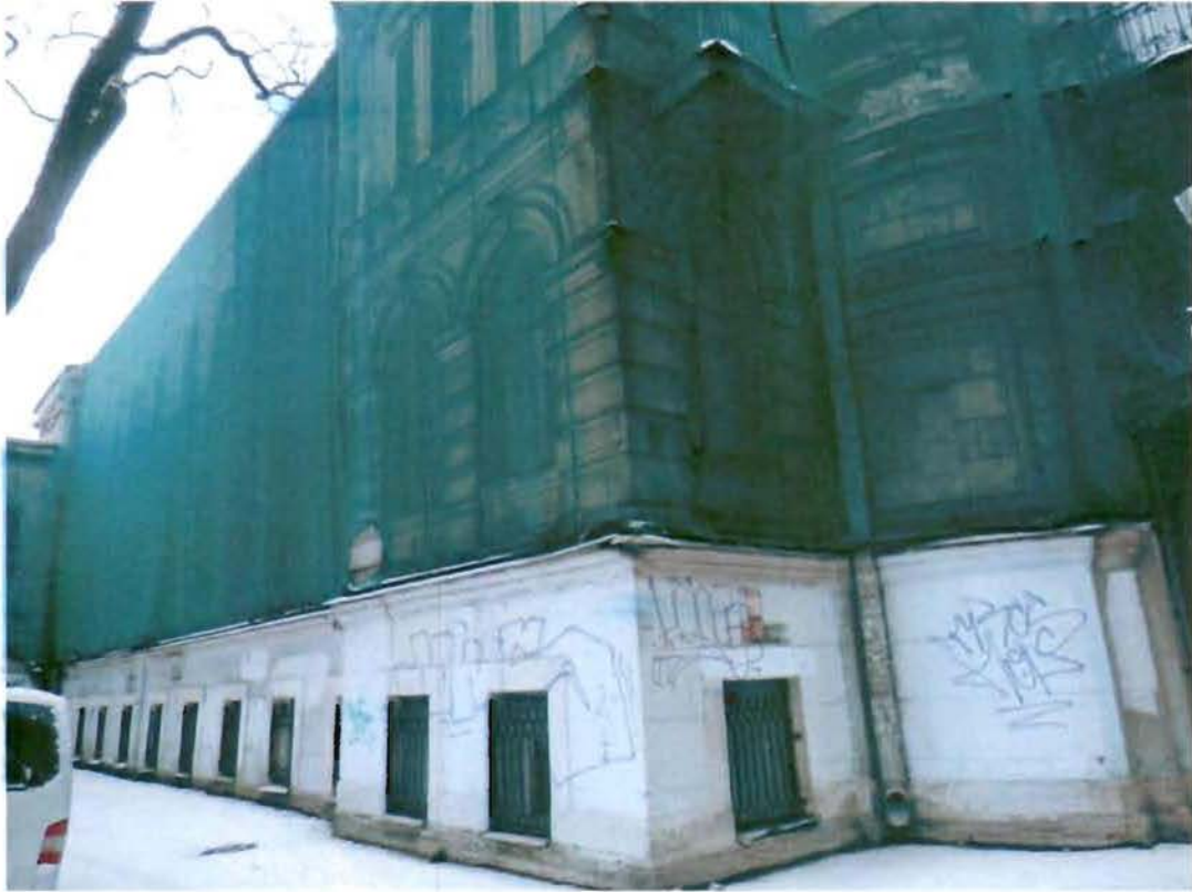
5. Северный флигель (фрагмент южной части фасада)
