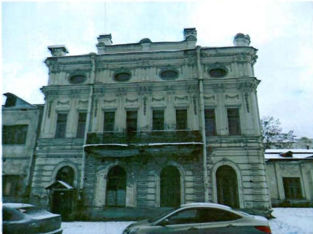
2. Особняк (западный фасад)
