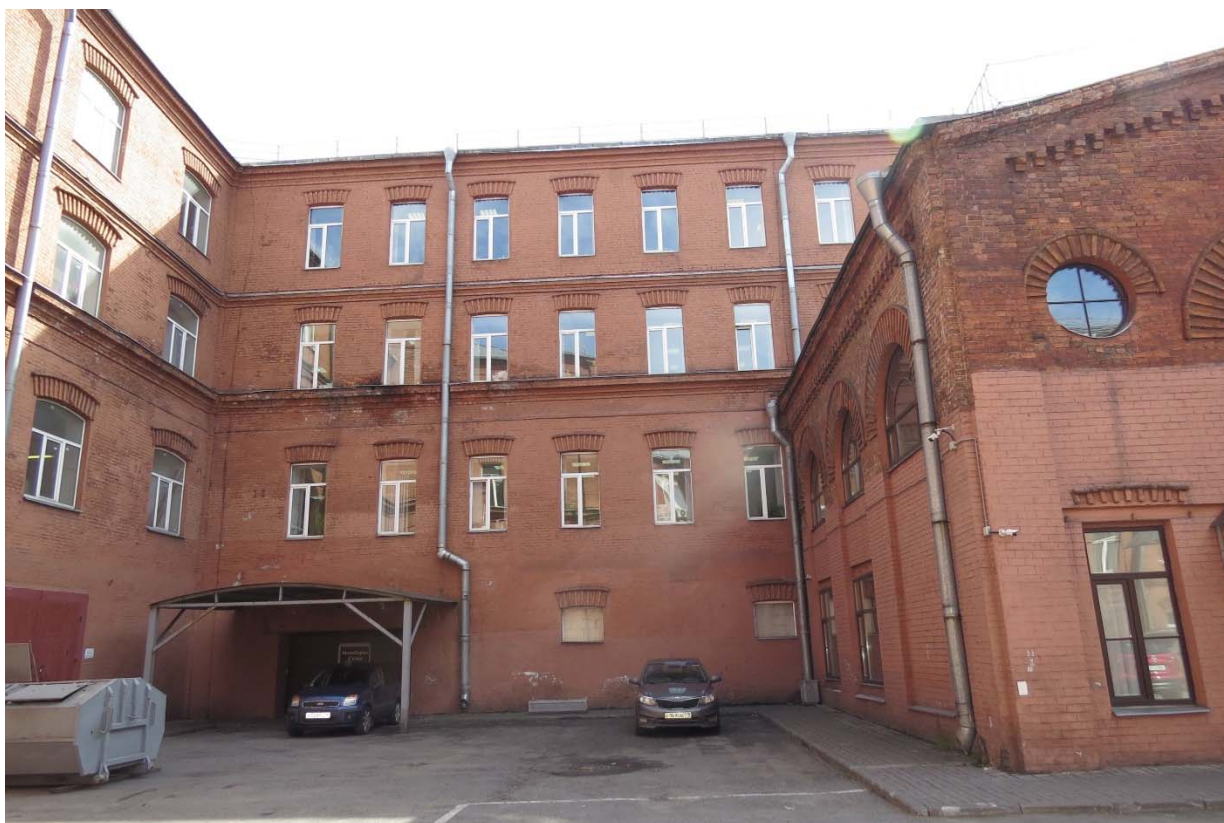
Фото 1. Северный фасад здания. Фрагмент. Полуокна первого этажа – проём в границах проектирования (подлежат раскрытию с последующей установкой оконного заполнения).
