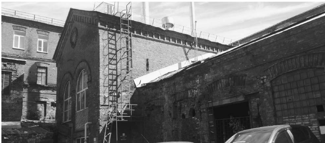
12. Комплекс товарищества Российско-американской резиновой мануфактуры «Треугольник» (80 производственных корпусов, соединенных переходами). Котельная. Штиглиц М.С. 17.11.2017 г.
