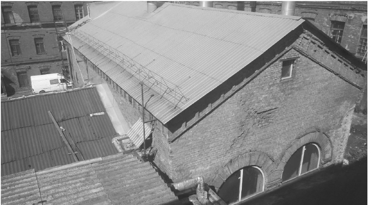
17. Комплекс товарищества Российско-американской резиновой мануфактуры «Треугольник» (80 производственных корпусов, соединенных переходами). Котельная. Штиглиц М.С. 17.11.2017 г.
