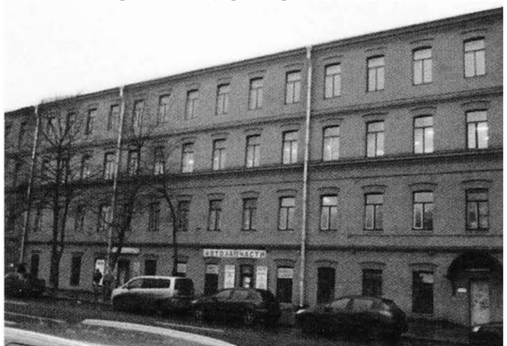
4. Комплекс товарищества Российско-американской резиновой мануфактуры «Треугольник» (80 производственных корпусов, соединенных переходами). Обводного кан. наб., 134-136-138, корп. №54, лит.А. Дворовый фасад. Штиглиц М.С. 17.11.2017 г.
