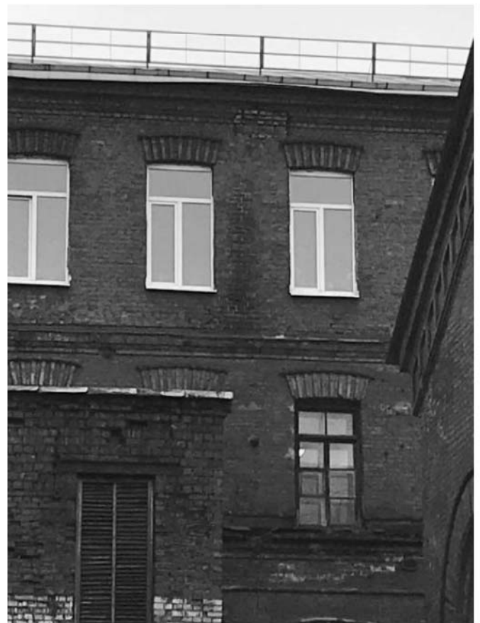
6. Комплекс товарищества Российско-американской резиновой мануфактуры «Треугольник» (80 производственных корпусов, соединенных переходами). Обводного кан. наб., 134-136-138, корп. №54, лит. А. Дворовый фасад. Штиглиц М.С. 17.11.2017 г.
