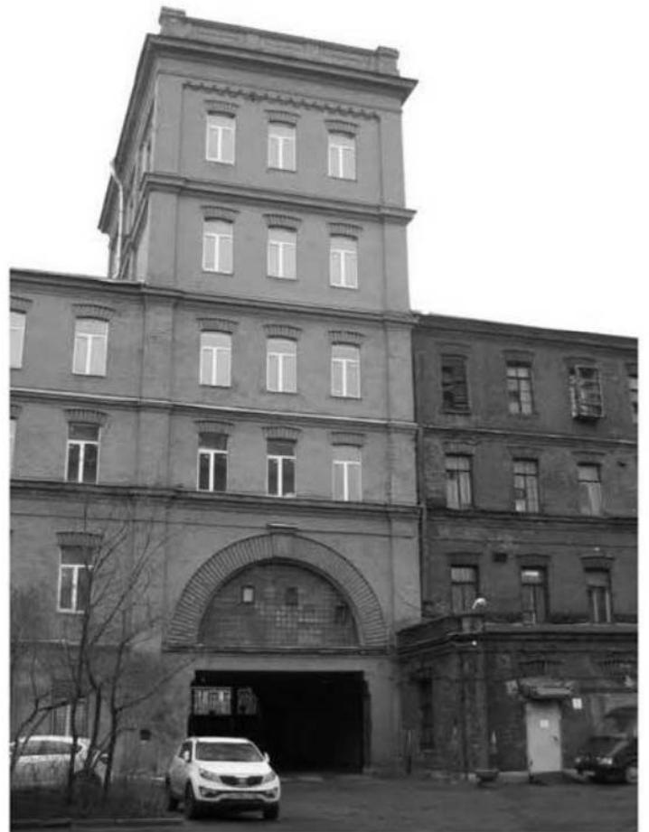
3. Комплекс товарищества Российско-американской резиновой мануфактуры «Треугольник» (80 производственных корпусов, соединенных переходами). Обводного кан. наб., 136, корп. 1, лит.Б. Дворовый фасад. Штиглиц М.С. 17.11.2017
