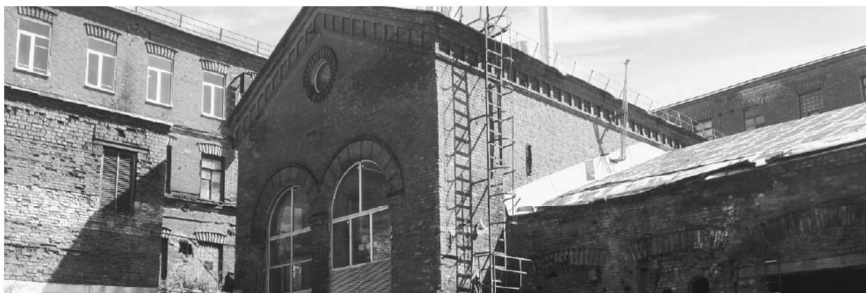
10. Комплекс товарищества Российско-американской резиновой мануфактуры «Треугольник» (80 производственных корпусов, соединенных переходами). Котельная. Штиглиц М.С. 17.11.2017 г.
