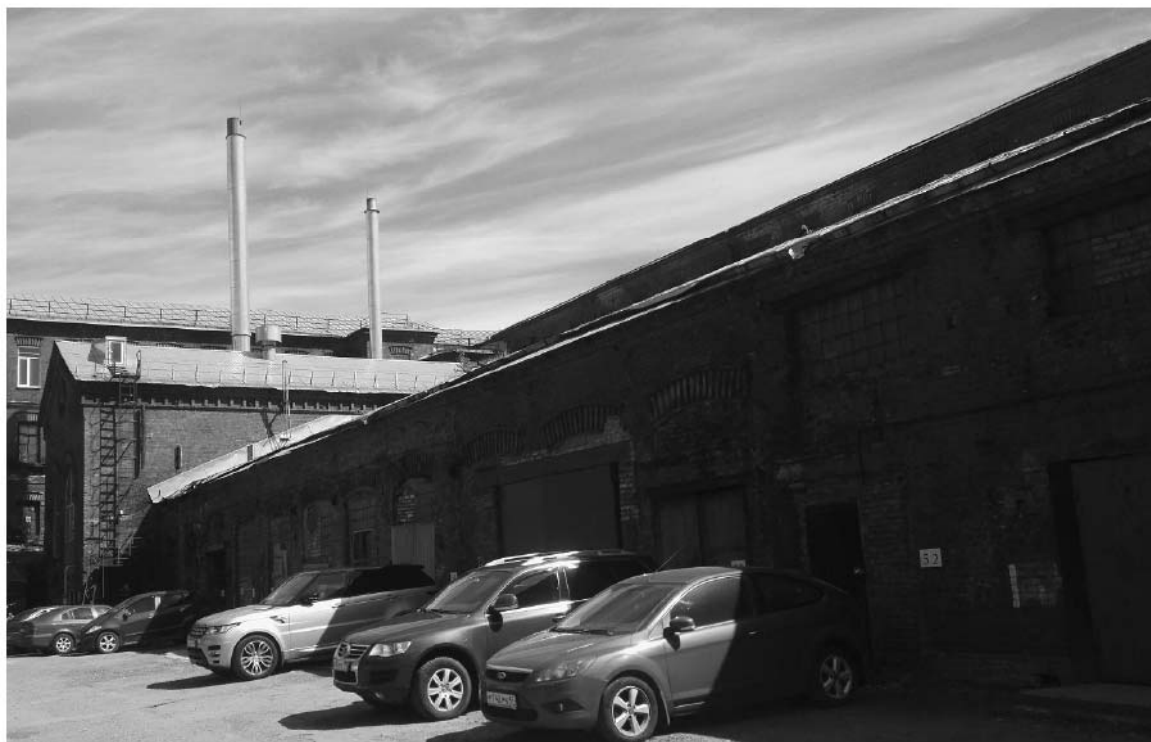
13. Комплекс товарищества Российско-американской резиновой мануфактуры «Треугольник» (80 производственных корпусов, соединенных переходами). Котельная. Штиглиц М.С. 17.11.2017 г.
