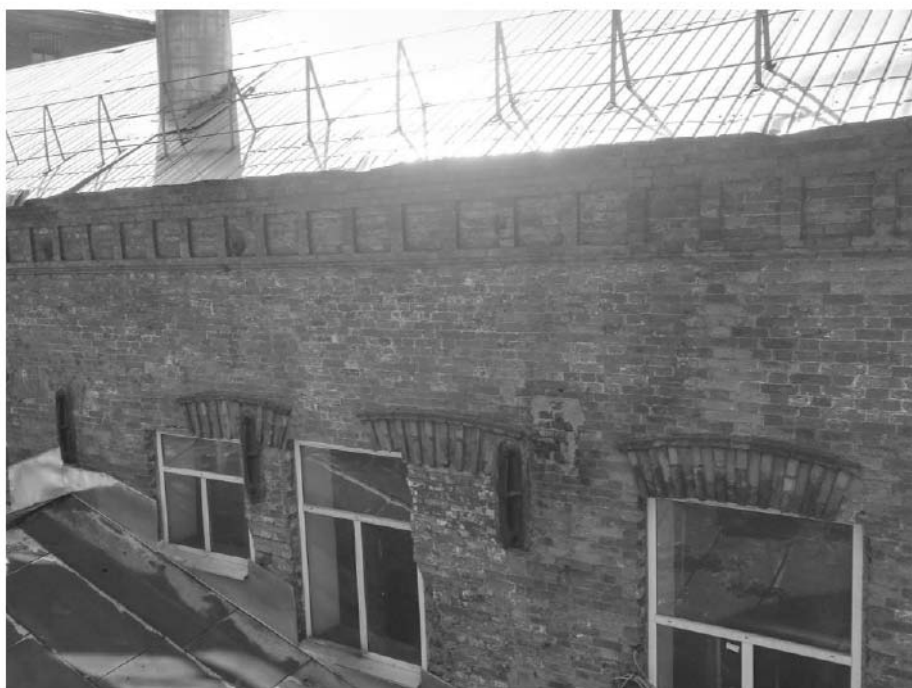
14. Комплекс товарищества Российско-американской резиновой мануфактуры «Треугольник» (80 производственных корпусов, соединенных переходами). Котельная. Штиглиц М.С. 17.11.2017 г.
