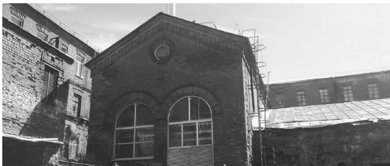
11. Комплекс товарищества Российско-американской резиновой мануфактуры «Треугольник» (80 производственных корпусов, соединенных переходами). Котельная. Штиглиц М.С. 17.11.2017 г.
