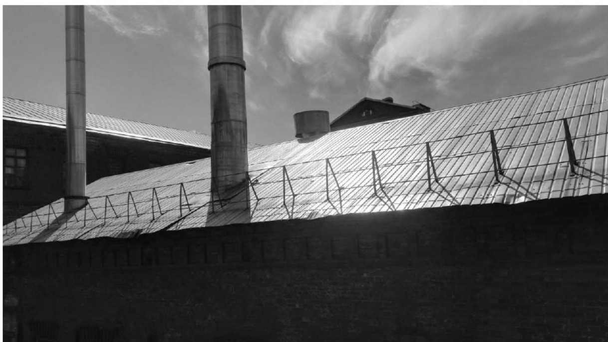
15. Комплекс товарищества Российско-американской резиновой мануфактуры «Треугольник» (80 производственных корпусов, соединенных переходами). Котельная. Штиглиц М.С. 17.11.2017 г.
