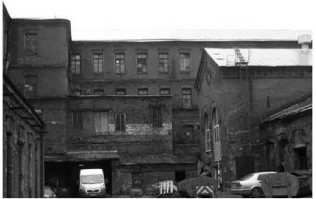
5. Комплекс товарищества Российско-американской резиновой мануфактуры «Треугольник» (80 производственных корпусов, соединенных переходами). Обводного кан. наб., 134-136-138, корп. №54, лит. А. Дворовый фасад. Штиглиц М.С. 17.11.2017 г.
