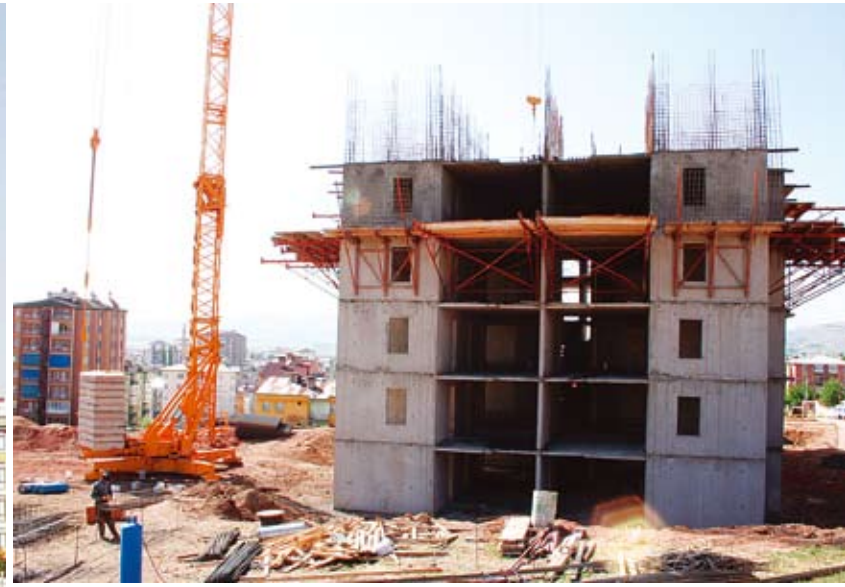
İzmit tünel kalıplı konut inşaatı © http://www.panoramio.com adresinden alınmıştır.
