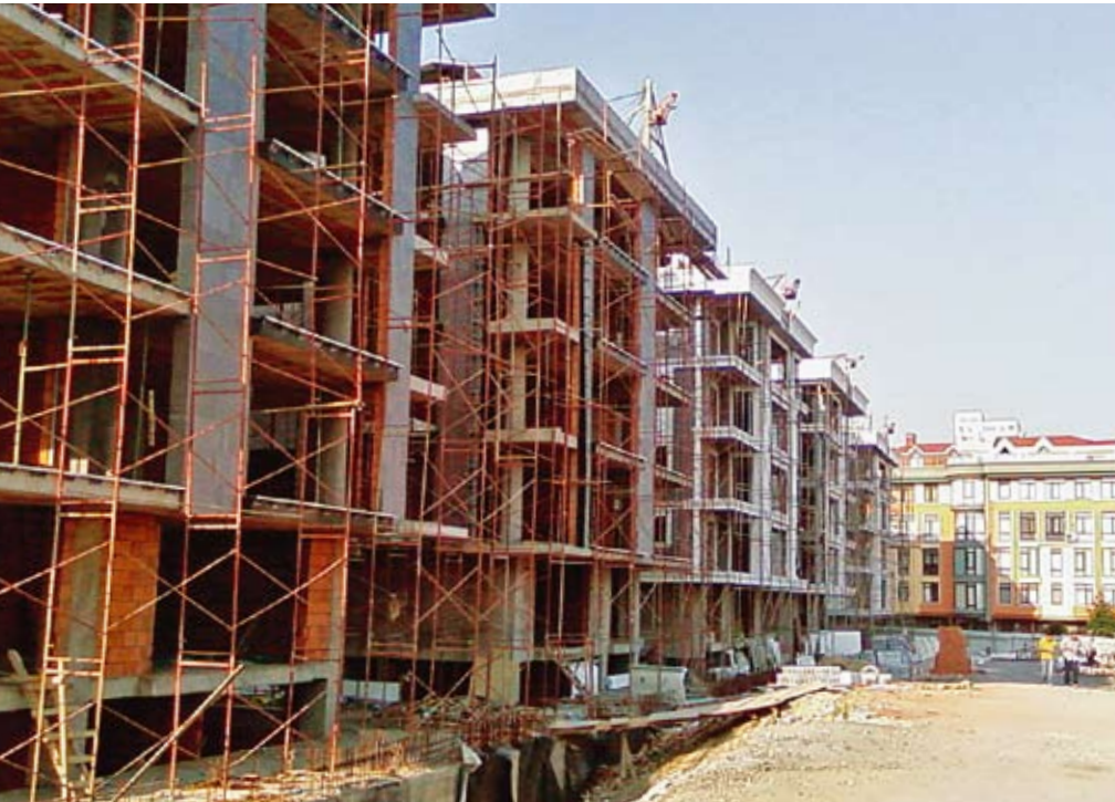
İzmit tünel kalıplı konut inşaatı © http://www.panoramio.com adresinden alınmıştır.
