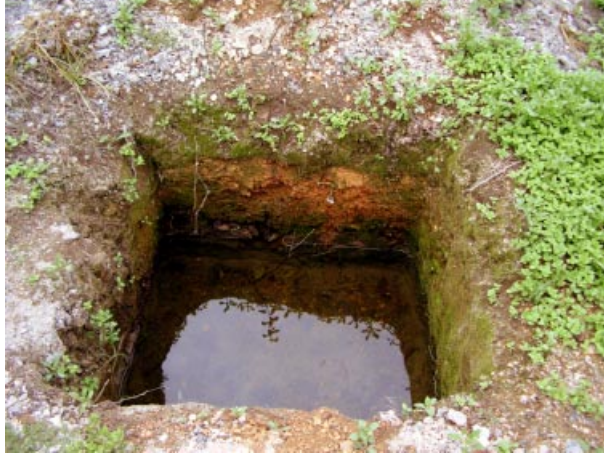
Foto 3. Calicata que muestra problemas de drenaje en el subsuelo. Obsérvese el espejo de agua que indica acumulación de esta. Santa Inés, La Laguna, San Vicente de Tagua-Tagua. Región de O'Higgins.
