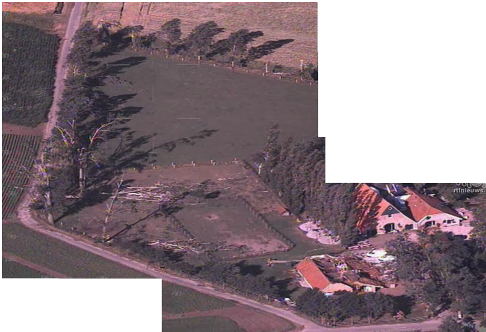
Figuur 42. Schade aan de bomen langs het pad op locatie E,F en G in figuur 30 (Bron:RTL-nieuws)
