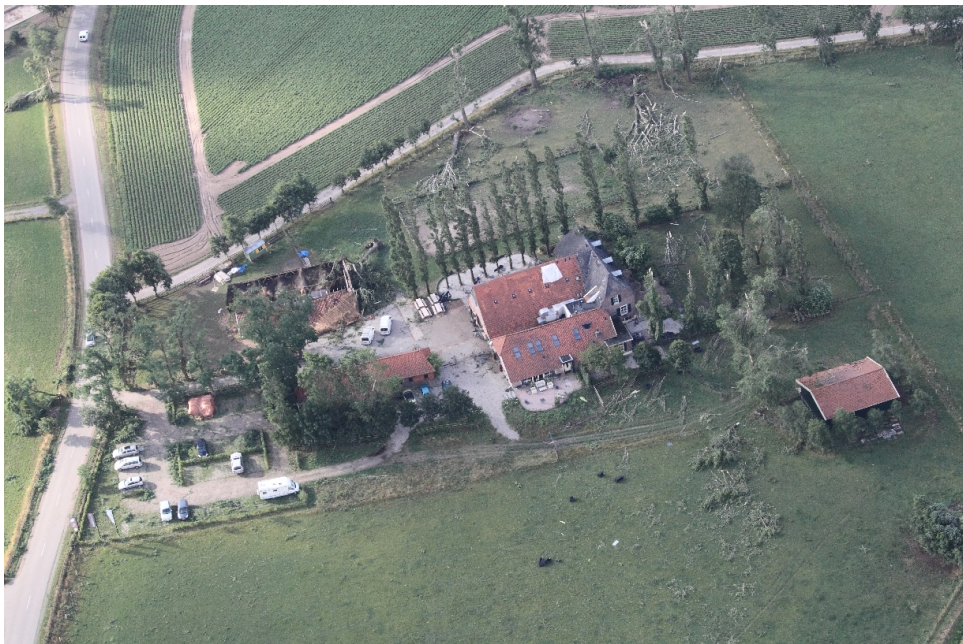
Figuur 41. Schadesporen bij het hotel-restaurant op locatie A (Bron: KLPD)
