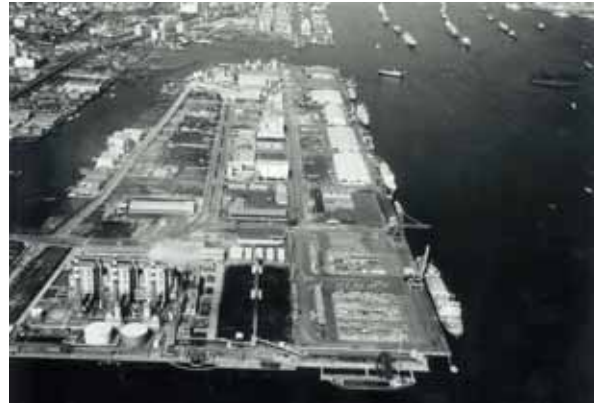
完成した東京電力品川発電所(1960年)
