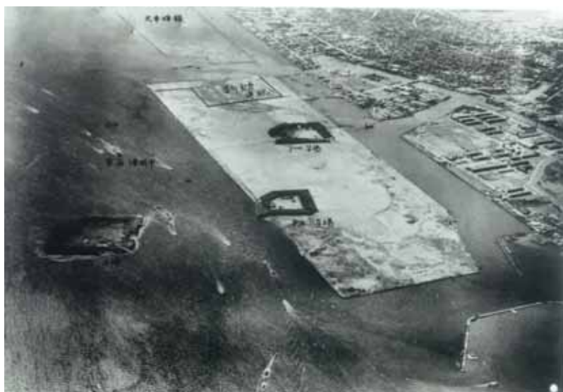
品川埠頭の埋立工事
