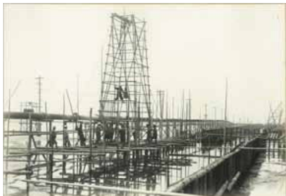
豊洲埠頭の埋立工事（1948）
