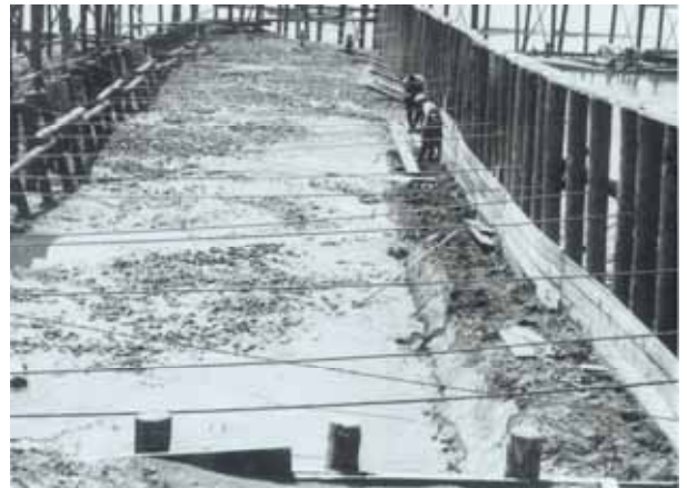
埋立工事風景
