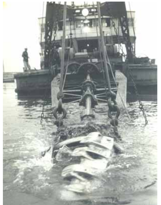
しゅんせつによる埋立て
