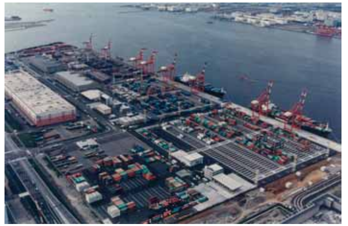
全バース完成した青海コンテナ埠頭（1996年）
