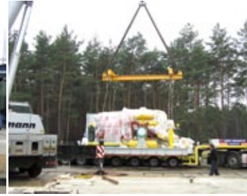
DOSTAWA AGREGATU SPRĘŻAJĄCEGO NA BUDOWĘ I POSADWIENIE GO NA FUNDAMENCIE
