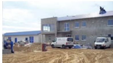
WEWNĄTRZ BUDYNKU ADMINISTRACYJNO-SOCJALNEGO I MAGAZYNOWO-SERWISOWEGO TRWAJĄ PRACE INSTALACYJNE
