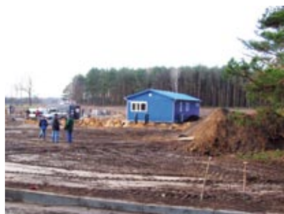
PRACE BUDOWLANE NA OG PRZYŁĘK
