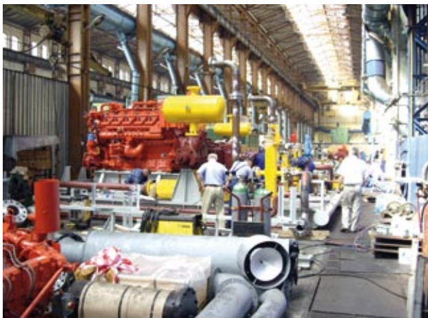
MONTAŻ FABRYCZNY ZESTAWU SPRĘŻAJĄCEGO WYKONAŁA FIRMA ABB Z ELBLĄGA
