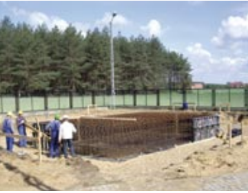
BUDOWA FUNDAMENTÓW POD ZESTAW SPRĘŻAJĄCY
