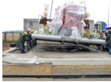
DOSTAWA AGREGATU SPRĘŻAJĄCEGO NA BUDOWĘ I POSADWIENIE GO NA FUNDAMENCIE
