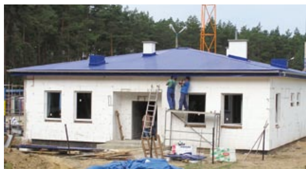
PRACE WYKOŃCZENIOWE PRZY NOWYM BUDYNKU ADMINISTRACYJNO-SOCJALNYM
