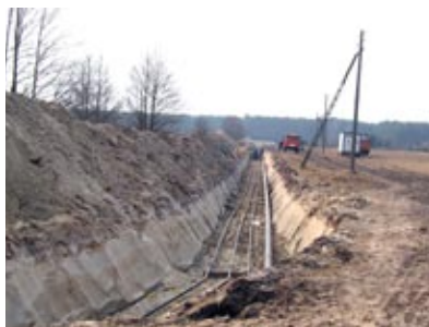
BUDOWA KOLEKTORÓW ZBIORCZYCH DO OG PRZYŁĘK
