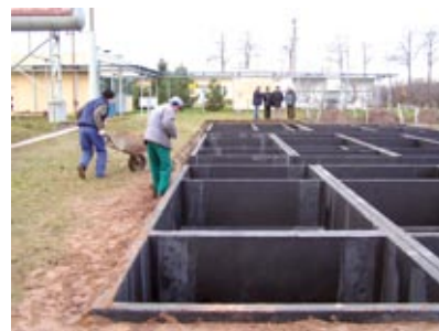
FUNDAMENTY POD KONTENERY TECHNOLOGICZNE
