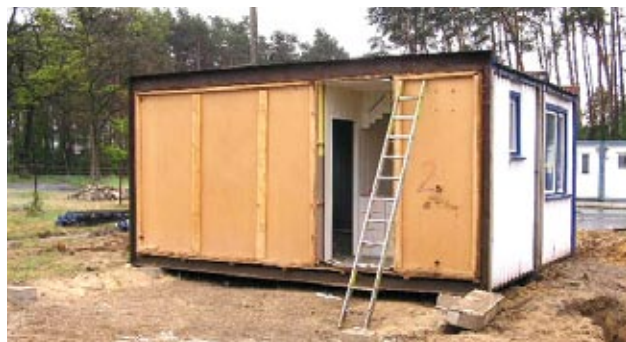
ROZBIÓRKA STAREGO BUDYNKU ADMINISTRACYJNEGO
