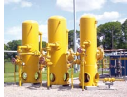
ODDZIELACZE STOJĄCE WODY ZŁOŻOWEJ
