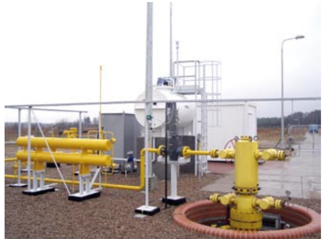
STREFA S-1 WYPOSAŻONA JEST W AUTOMATYKĘ POZWALAJĄCĄ NA WTŁACZANIE METANOLU
