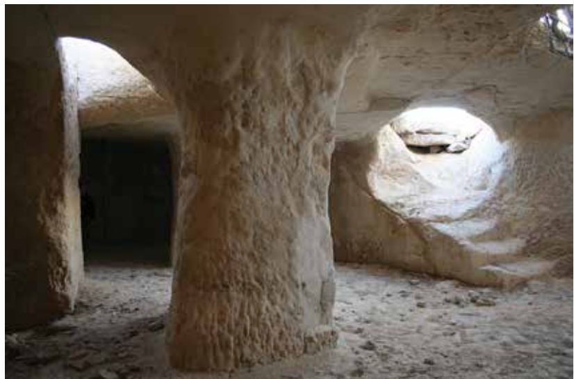
תמונה 15. תוכה של מאגורה בבורות חצץ, מקבץ של מאגורות מדרון. בתמונה רואים משמאל את פתח המילוי אליו מתנקזות תעלות הטיה, במרכז את עמוד התמך, ומימין את פתח הכניסה והמדרגות.
