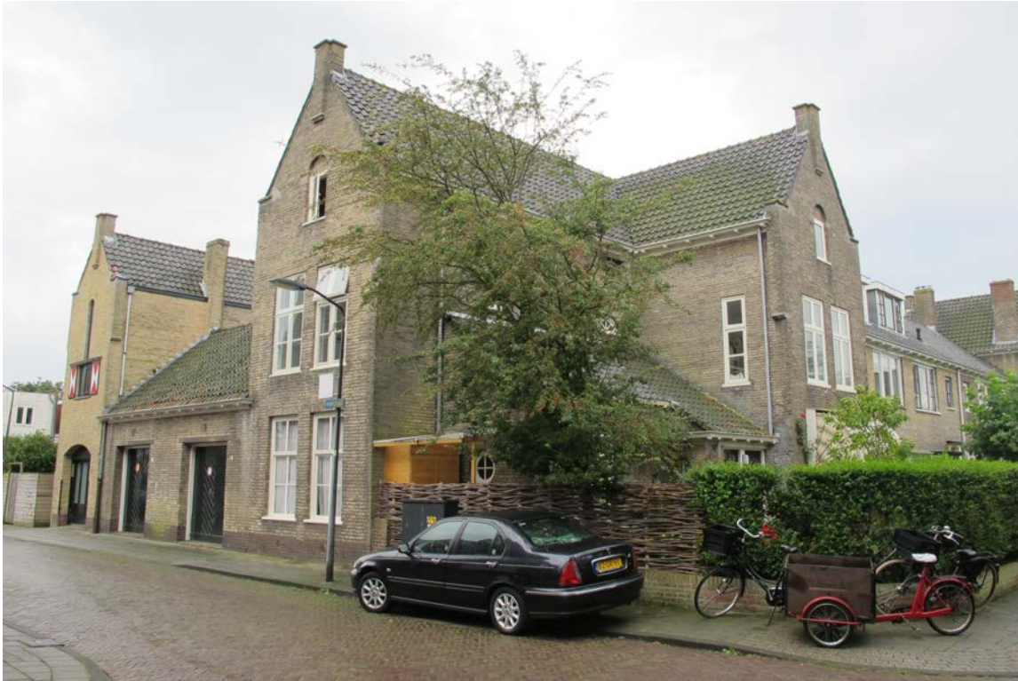
Rond 1939-1940 gebouwd complex in Delftse Schoolstijl aan de Theemsstraat en Duinsstraat
